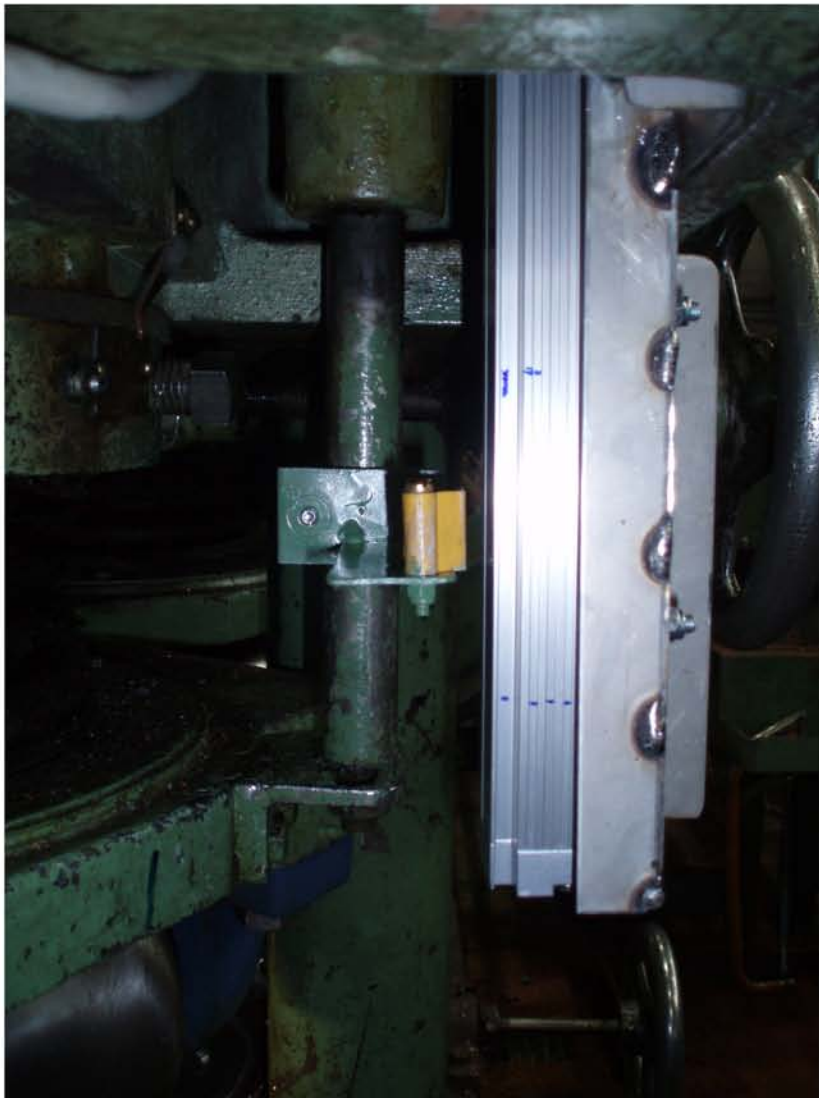
Kuva 25. Novotecknikin TLM-lineaarianturi asennettuna kiinnikkeiden avulla paikoilleen.
