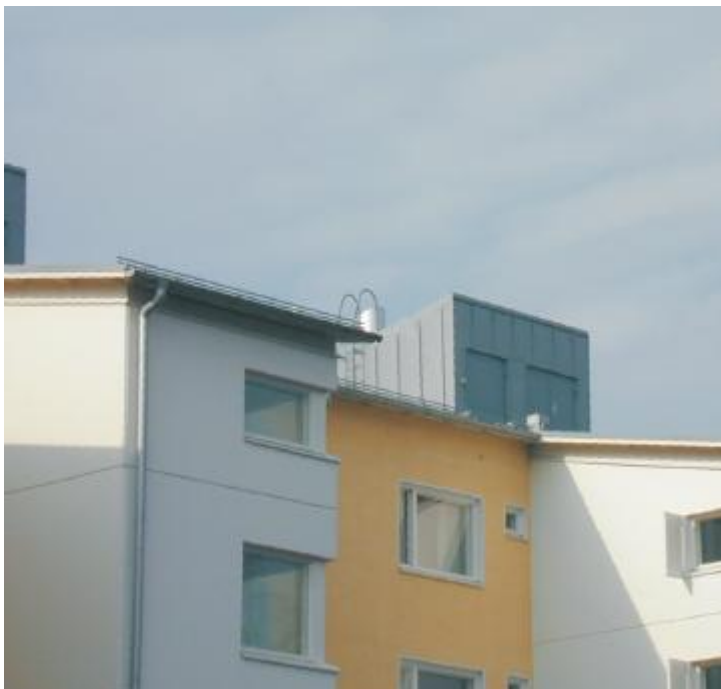
Kuva 11. Katolle sijoitettu erillinen ilmanvaihtokonehuone (1)
