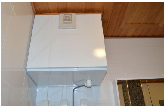
Kuva 10. Vallox-merkkinen asuntokohtainen ilmanvaihtokone (12)
