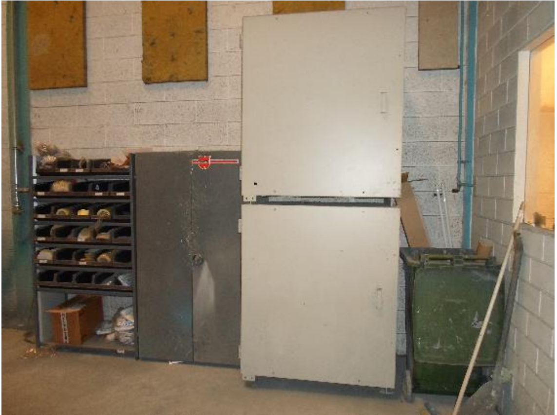
Kuva 16. Käytävä ennen erottelua.
