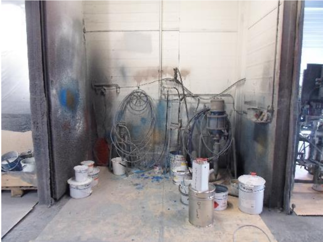
Kuva 13. Maalaamon maalipumppujen edusta ennen erottelua.
