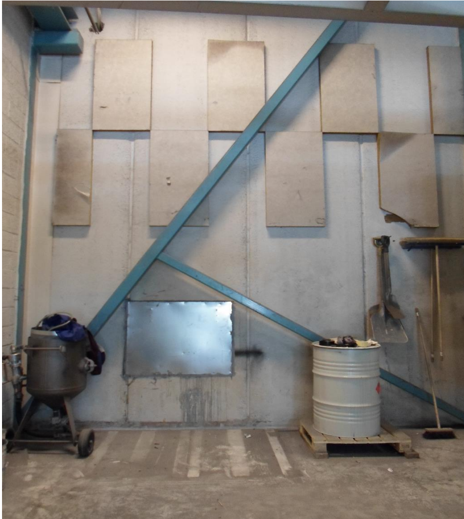
Kuva 20. Tila 3:ssa oleva seinä puhaltamon vierestä järjestelyn jälkeen.
