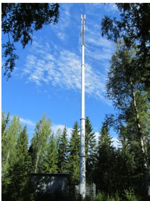
KUVA 8. Putkimasto jonka yläosa ristikkoo (Honkala 2015-10-11.)
