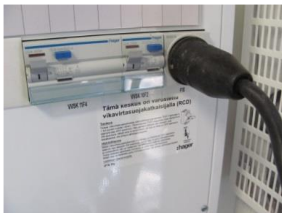
KUVA 51. Vikavirtasuojattu pistorasia (Honkala 2015-10-11.)
