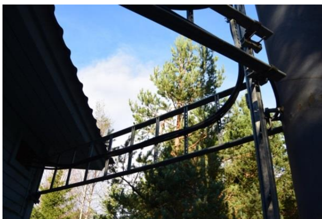
KUVA 62. Kaapelitikastus laitetilaan (Honkala 2015-10-11.)
