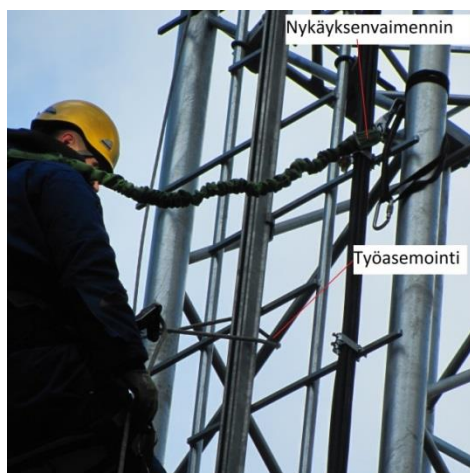
KUVA 38. Nykäyksenvaimennin ja työasemointi (Honkala 2015-10-11.)
