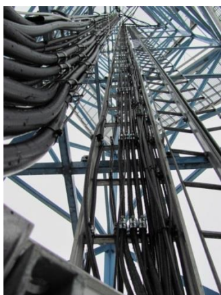
KUVA 61. Kaapelitikastus ja kiinnikkeet (Honkala 2015-9-18.)
