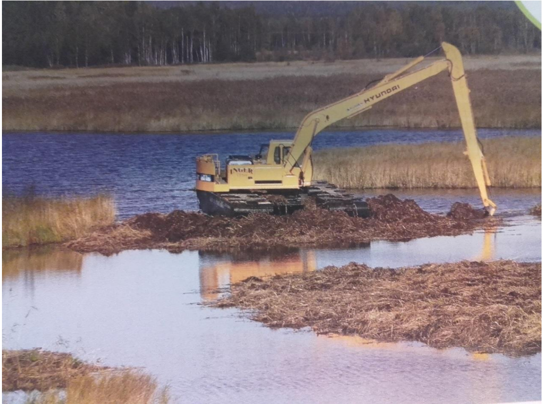
Kuva 14. Ruoppaus kesällä ponttooni-kaivinkoneella (Aitto-oja ym.- 2010, 26).
