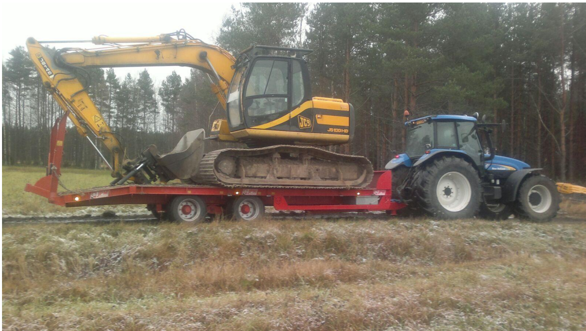
Kuva 7. Kaivinkoneen siirto kosteikolle
