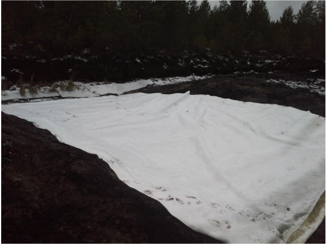
Kuva 10. Pohjapadon pohjalle asennettu suodatinkangas
