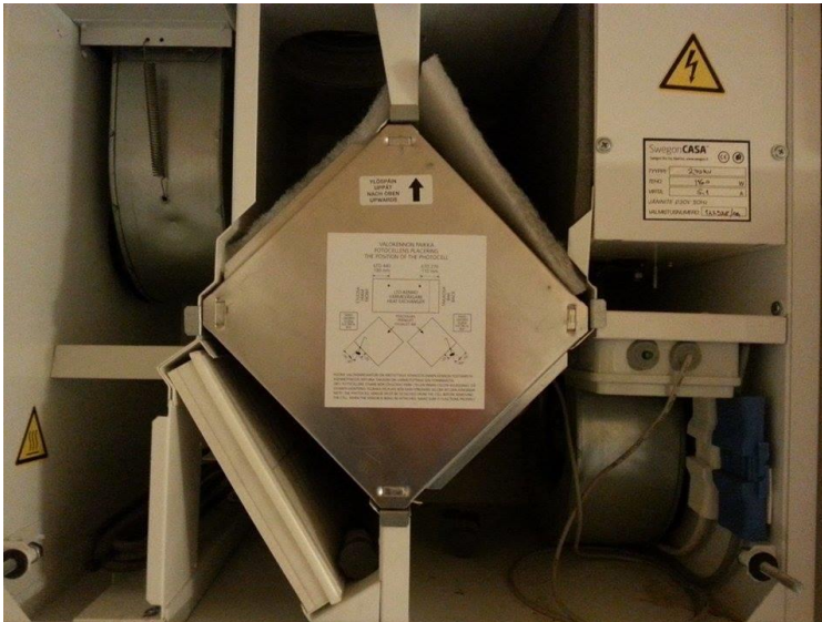
KUVA 2. Levylämmönsiirrin
