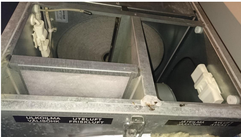
KUVA 3. Pyörivä lämmönsiirrin
