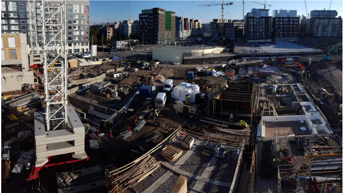
Kuva 1. Kvarteret Victoria -työmaa lokakuussa 2015.
