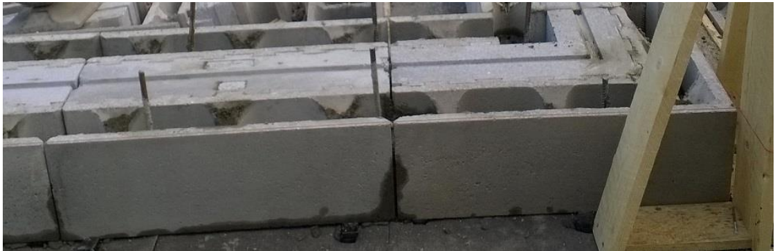
Kuva 7. Ensimmäisen harkkokerroksen paikalleen asentaminen kiilojen avulla.
