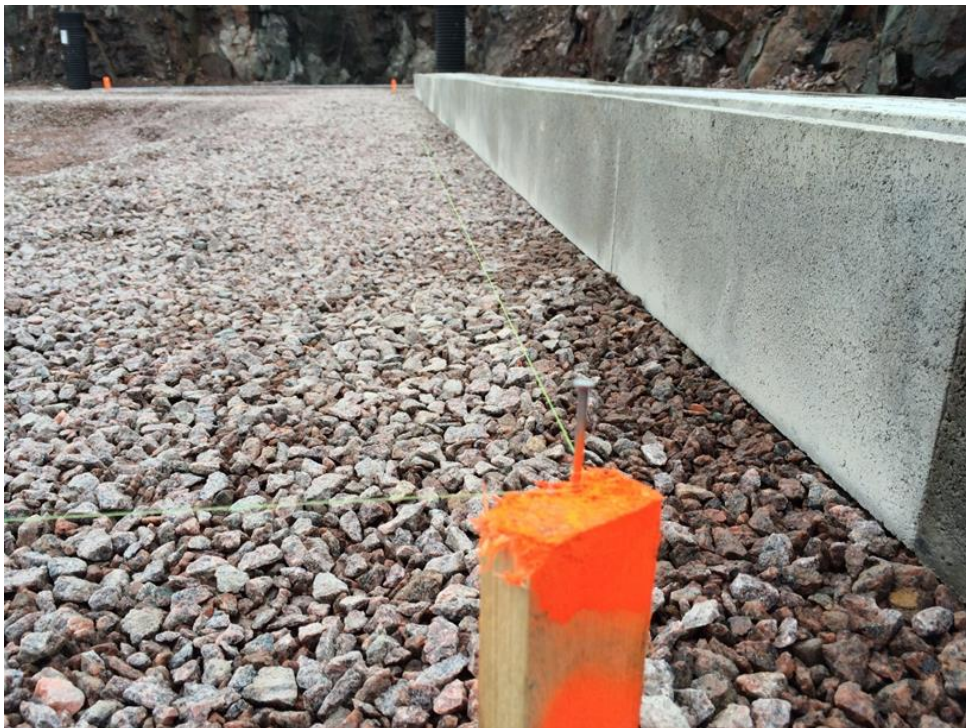
Kuva 2. Rakennuksen sokkelin linjan merkit ja linjauslangat.
