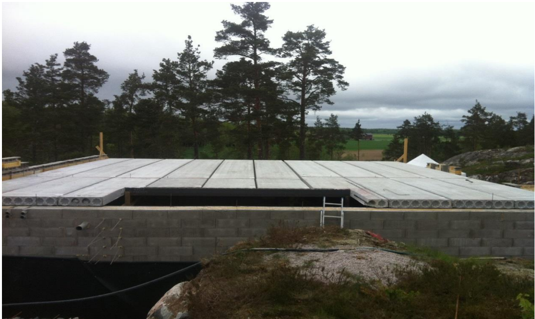
Kuva 10. Paikalleen asennetut ontelolaatat.
