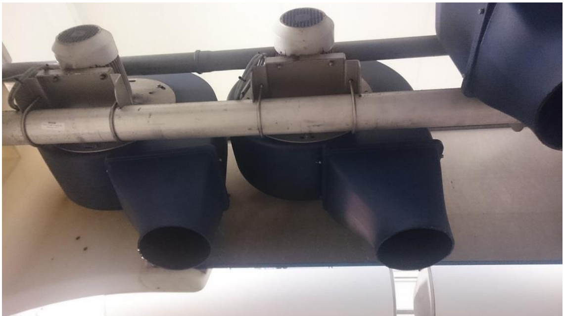
KUVA 16: Kuivauspuhaltimien kiinnitys metalliseen kehikkoon. (Niklas Vesterinen 2015)
