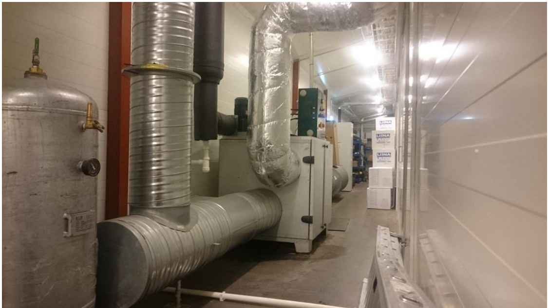
KUVA 9: Hallin kuivauslaitteisto 18 kW. (Niklas Vesterinen 2015)
