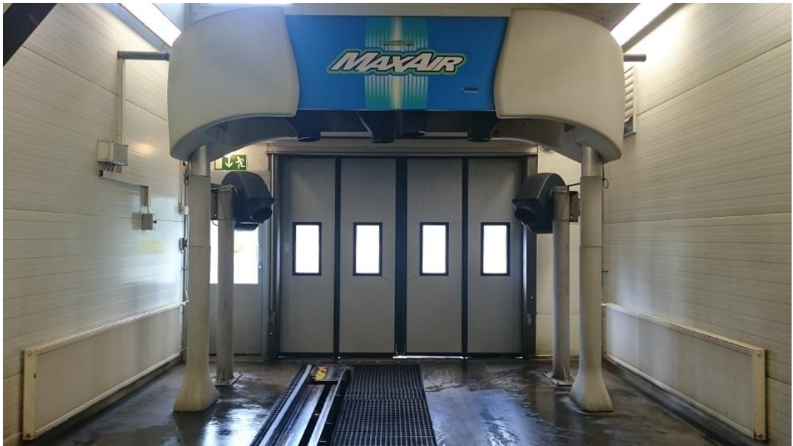
KUVA 6: Pesun kuivauspuhaltimet 6kpl. (Niklas Vesterinen 2015)
