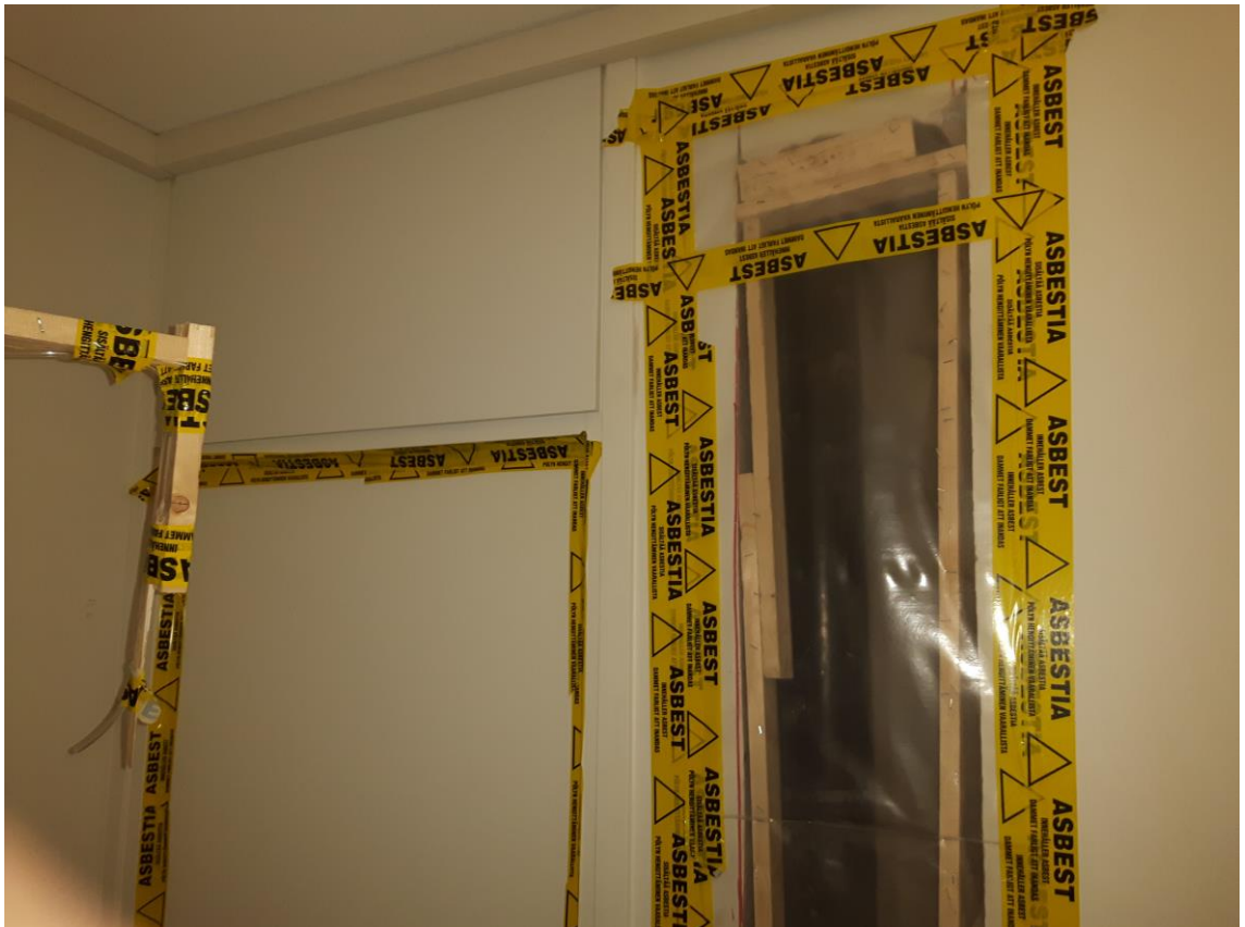
KUVA 5. Osastoinnin teippaukset kunnossa (Hyryläinen 2016)
