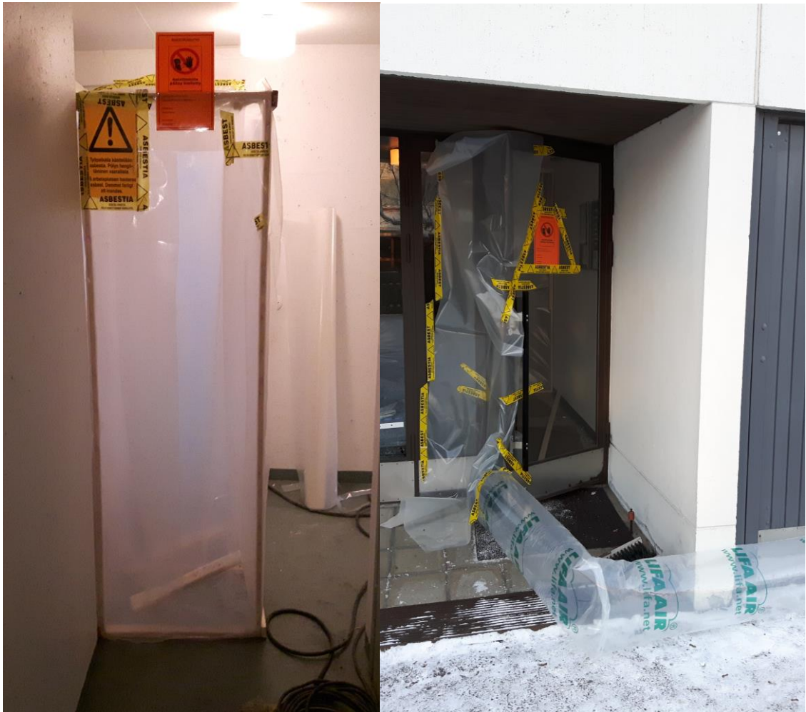
KUVA 6. Asbestitöistä kertovat varoitusmerkit tulee olla näkyvillä (Hyyryläinen 2016)
