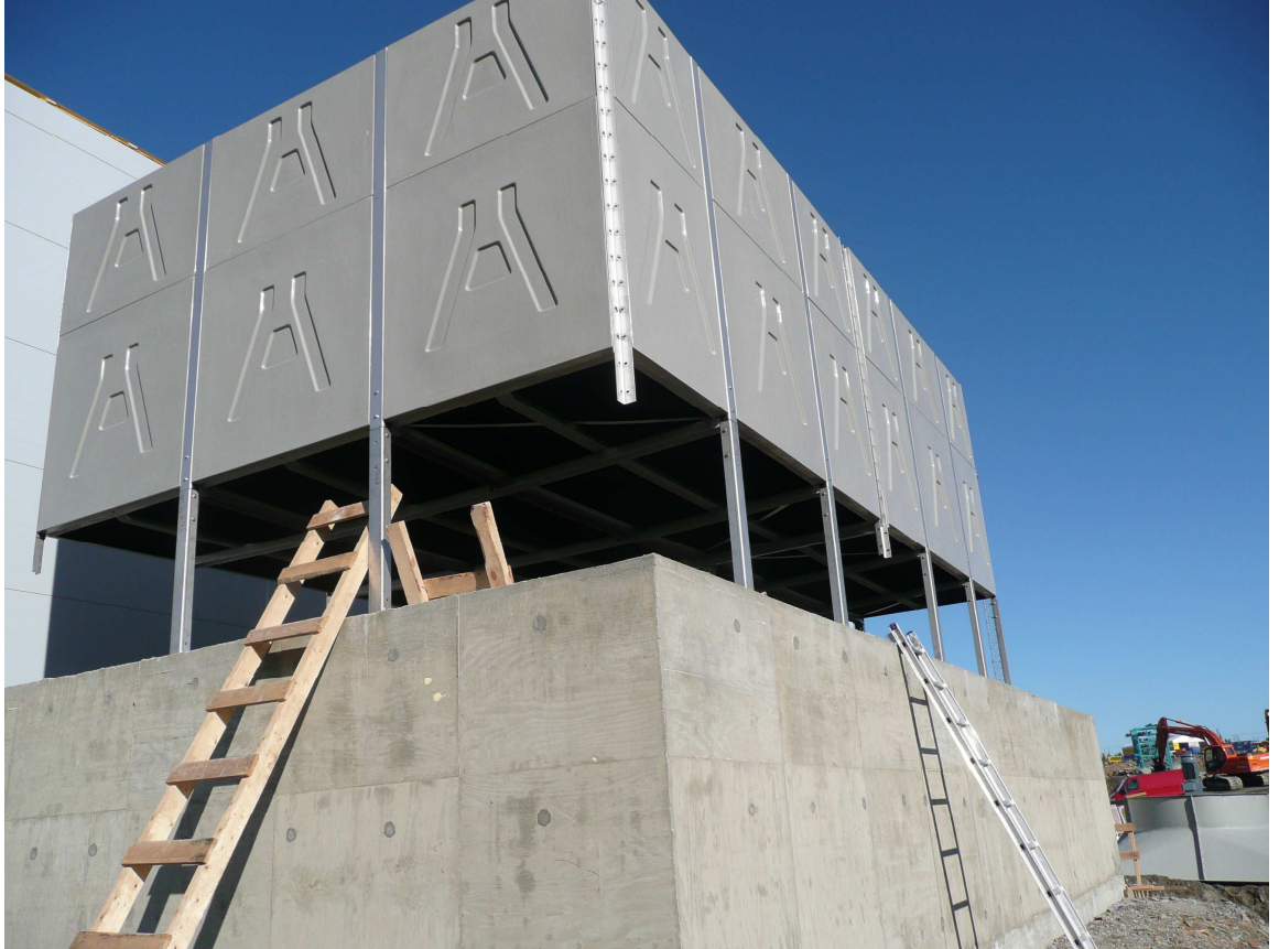
Kuva 24. Jäähdytystornit asennusvaiheessa. [7.]
