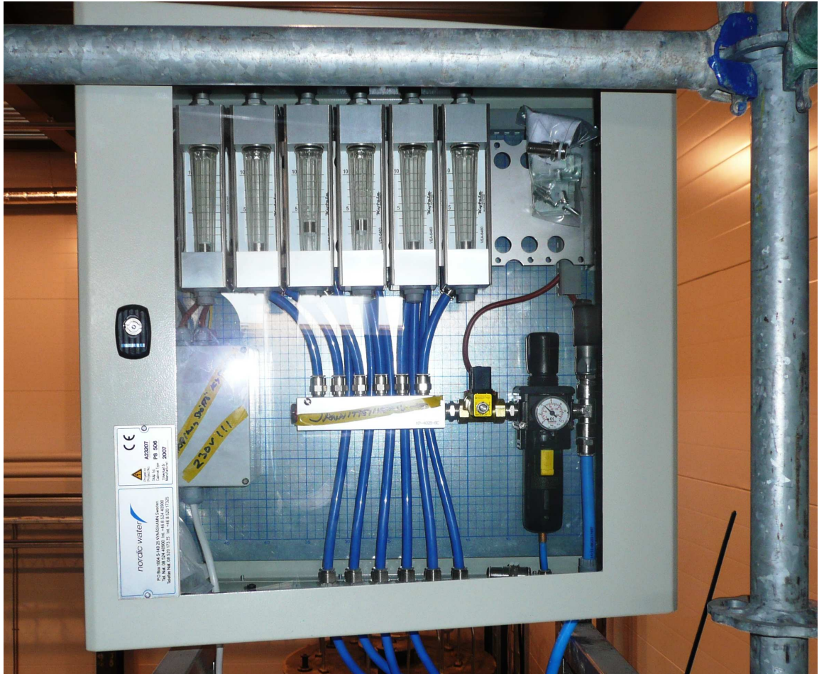
Kuva 25. Dynasandin pneumiikkaohjauskeskus. [7.]
