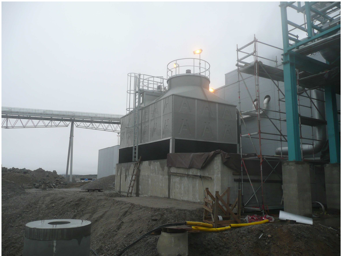
Kuva 20. Jäähdytystornit asennusvaiheessa. [7.]
