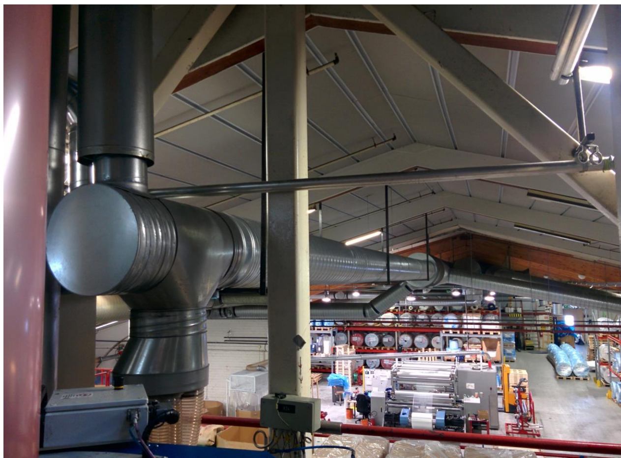
Figur 9. Nybyggd del av ventilation för varmluftsutsug ovanför huvudverktyget och sugpumpar till maskin nr5.
