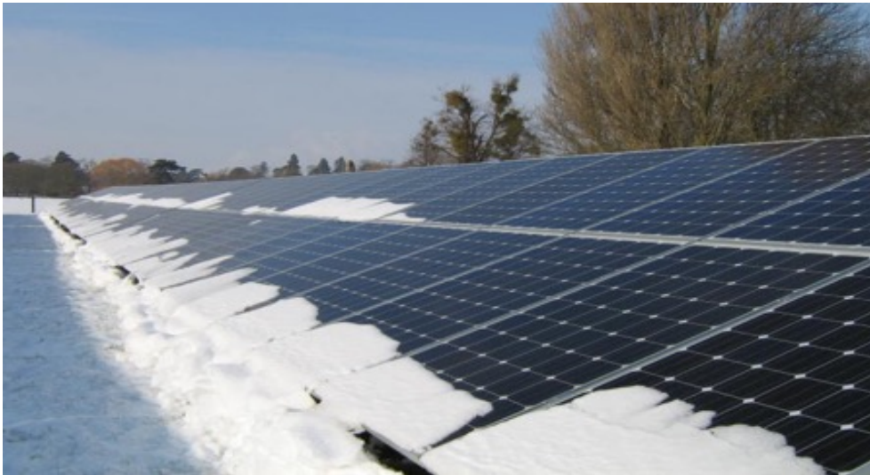
Kuva 18. Kertynyt lumi aurinkopaneelien pinnalla (Fireflower 2016)
