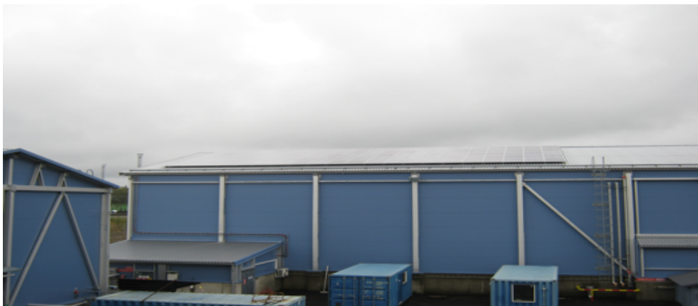
Kuva 20. 25 kilowatin aurinkosähköjärjestelmä (Rintala 2015)
