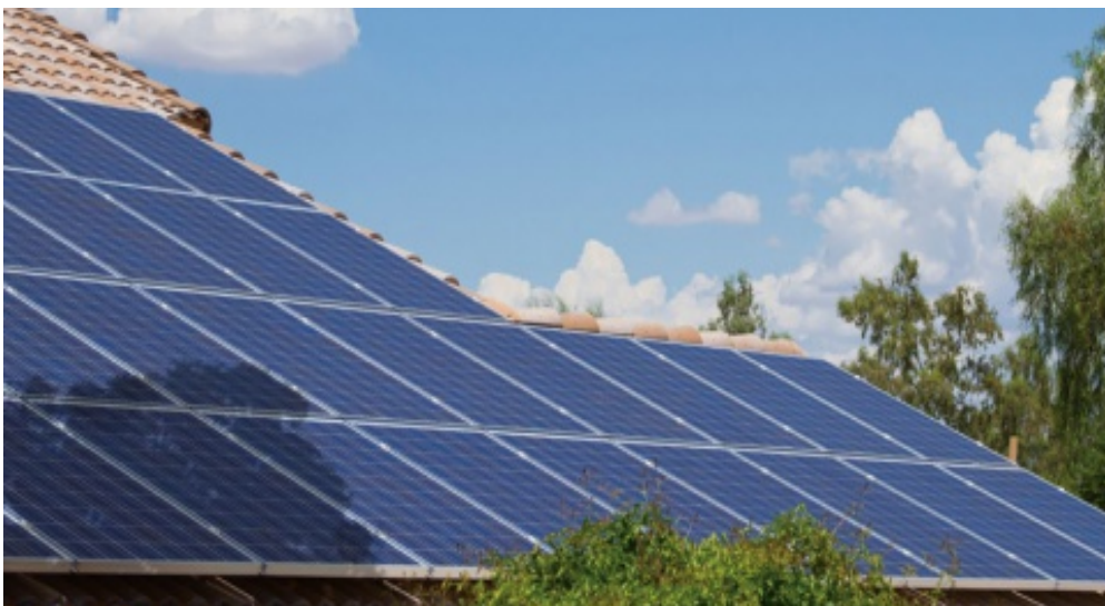
Kuva 19. Puiden varjo aurinkopaneelien päällä (Homepower.com 2016)
