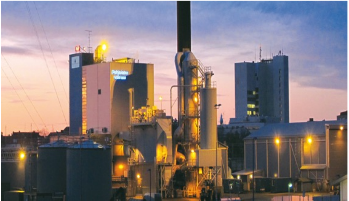
Kuva 1. Kemin Energia Oy:n lämpölaitos (Kemin Energia Oy 2015)
