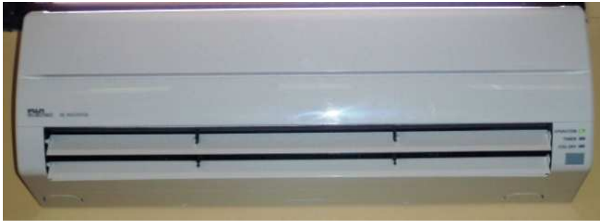
Kuva 6.2 Fuji Electricin ASYA 12LC sisäyksikkö
