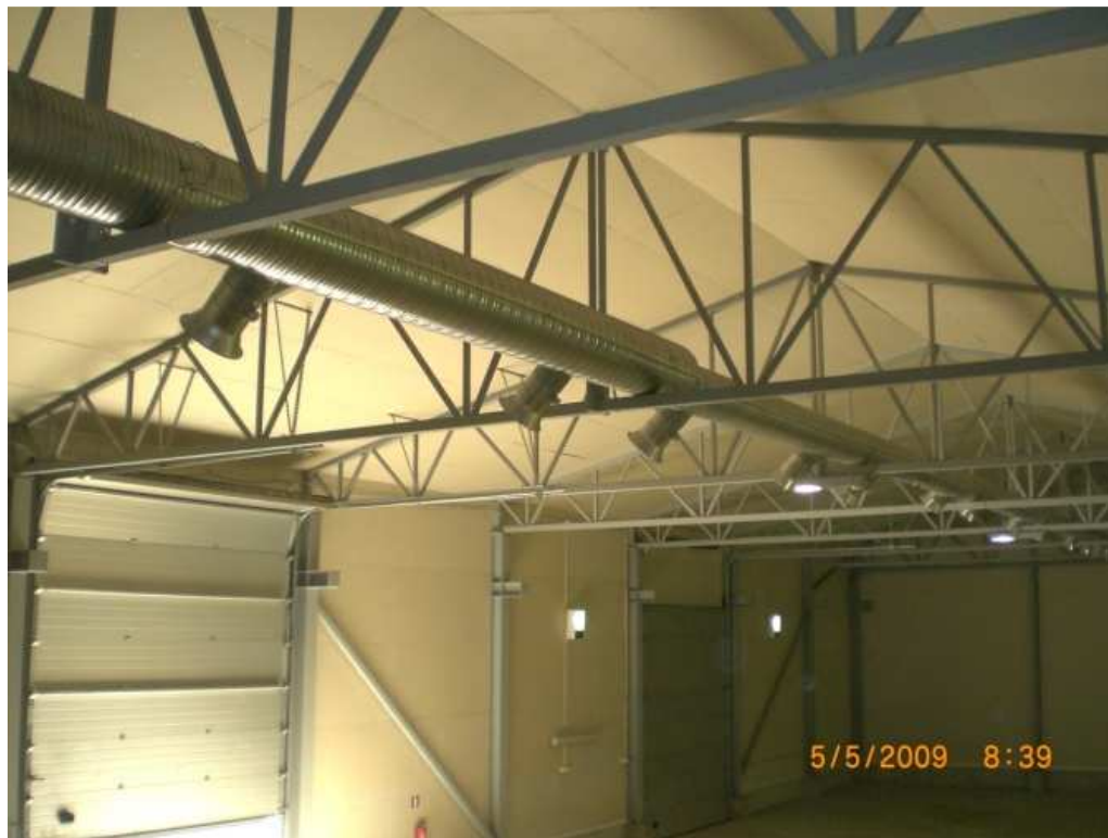
Kuva 2.3 Tuotantotilan poistokanava
