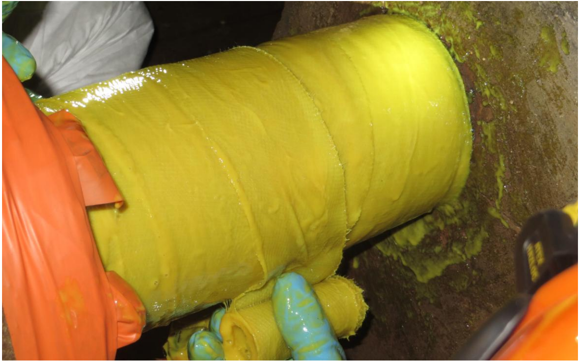
Kuva 11. Komposiitin kääriminen liuotinputken ympärille
