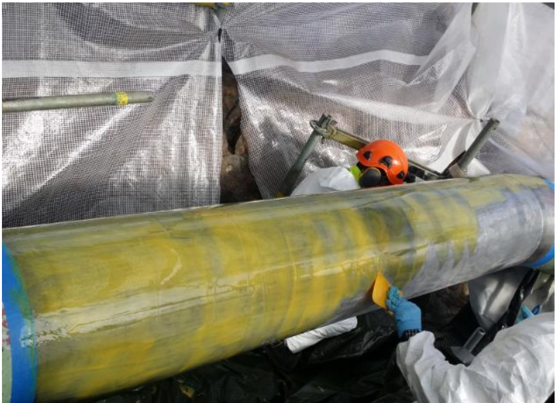
Kuva 5. Epoksihartsikerroksen levittäminen putken pinnalle
