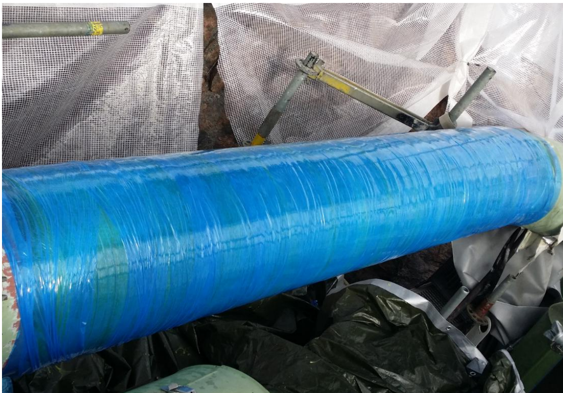
Kuva 8. Puristuskalvonauha käärittynä komposiittikorjauksen ympärille kovettumisen ajaksi
