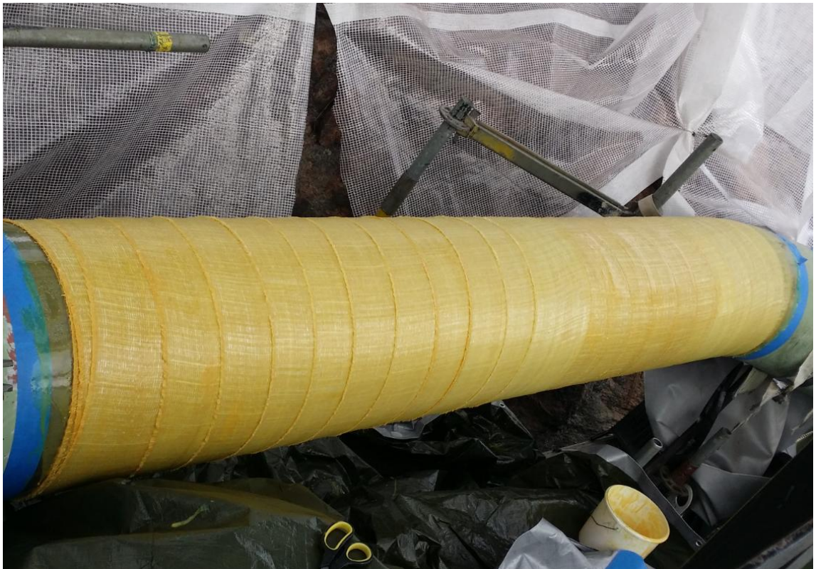
Kuva 7. Komposiittikuitunauhaa käärittynä putken ympäri 50 %:n päällekkäisyydellä
