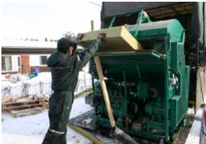
Kuva 1. Mineraalieristelevyt ja -palat rouhitetaan ja kuidutetaan hydraulisella eristekuiduttimella ja uusiokäytetään puhallusvillan joukossa.[4.]
