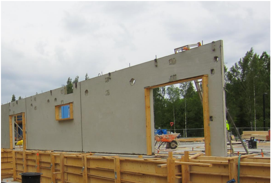
Kuva 2. Ulkoseinät on tuettu paikoilleen väliaikaisille elementtitiilla.
