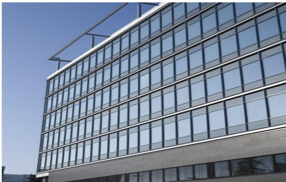
Kuva 1. Lasitettu julkisivu (Seloy materiaali)
