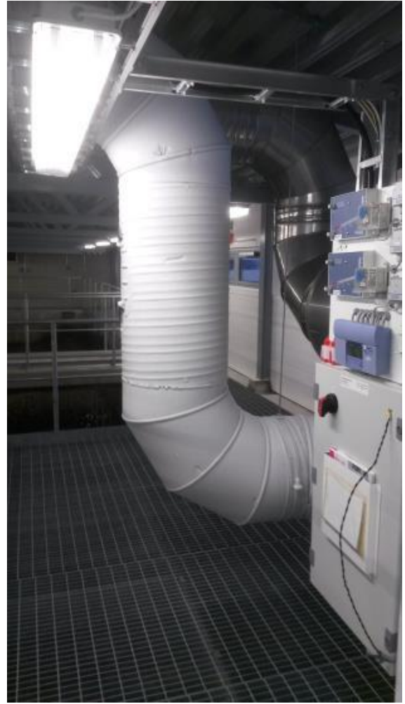
Kuva 23. LTO-kennon jäätyessä, myös kanavat jäätyvät kosteissa tiloissa.
