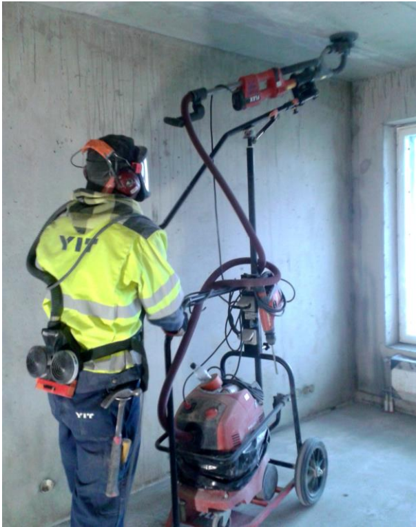
KUVA 11. Betonikaton hionta kirahvilla (Kuva: Anniina Tuulkari 2015)
