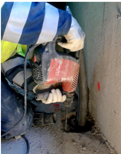
KUVA 12. Betonilattian piikkaus kombivasaralla (Kuva: Anniina Tuulkari 2015)
