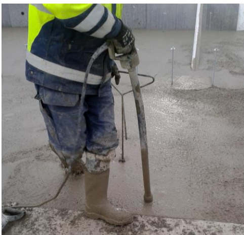
KUVA 14. Betonivalun sauvatärytys (Kuva: Anniina Tuulkari 2015)
