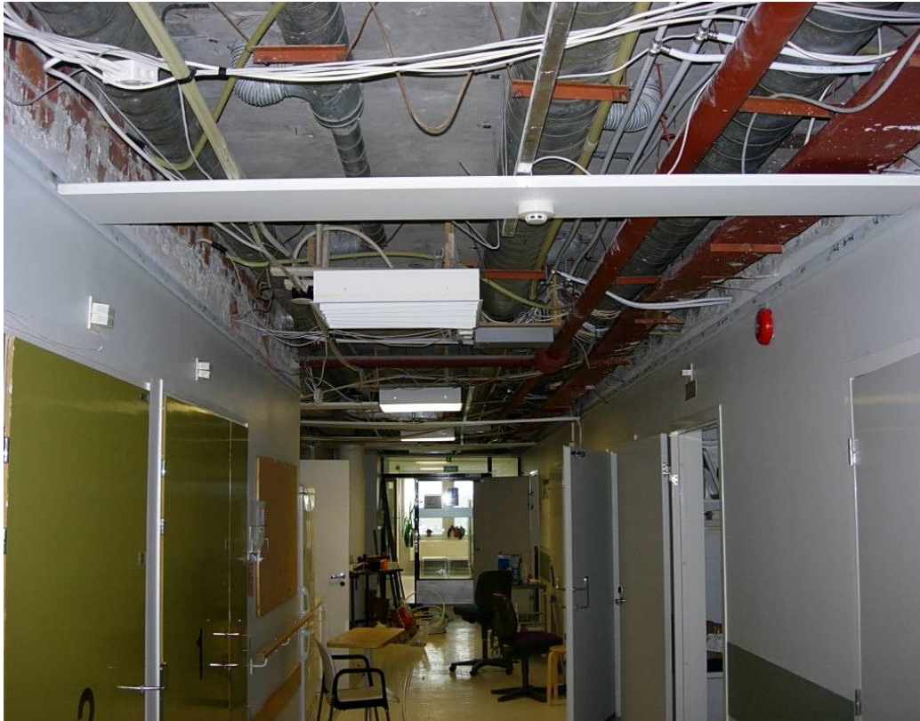
Kuva 8. Kerrosten välinen betonilaatta
