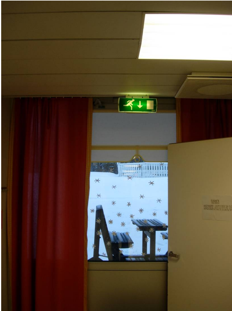
Kuva 10. Peltikatto osaston käytävällä sekä poistumisvalaisin
