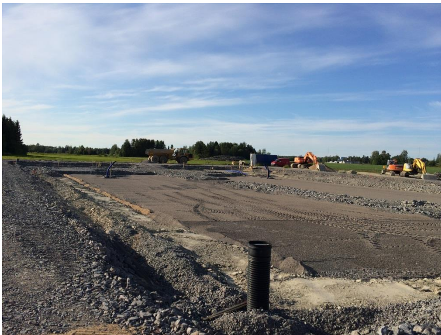
Kuva 4. Navetan pohjan mursketäyttö ja salaojat on tehty
