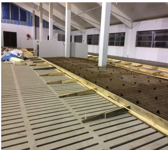
Kuva 16. Makuuparsien pohjat valmistuvat vauhdilla
