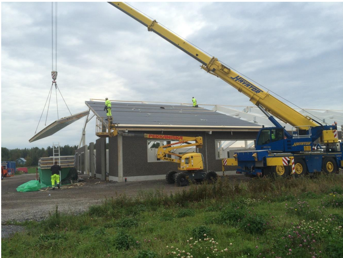
Kuva 12. Katon asennus on nopeaa toimintaa
