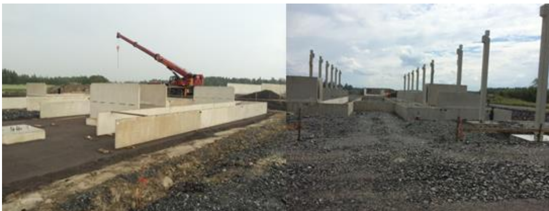
Kuva 5. Lietekuilujen ja pystypilarien asennus heinäkuussa
