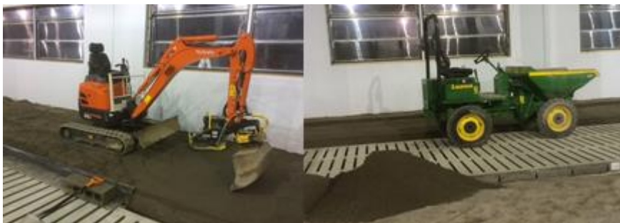
Kuva 15. Minikaivuri ja -dumperi kätevinä apuvälineinä
