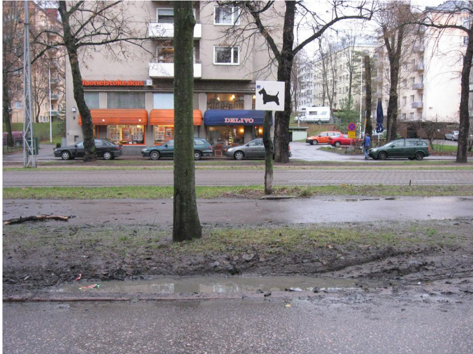
KUVA 11 Katunurmelle liikenteestä ja kiskojen kunnostuksesta aiheutunut vaurio. Munkkiniemenpuistotie, Munkkiniemi (Kuva: Inkeri Salo)
