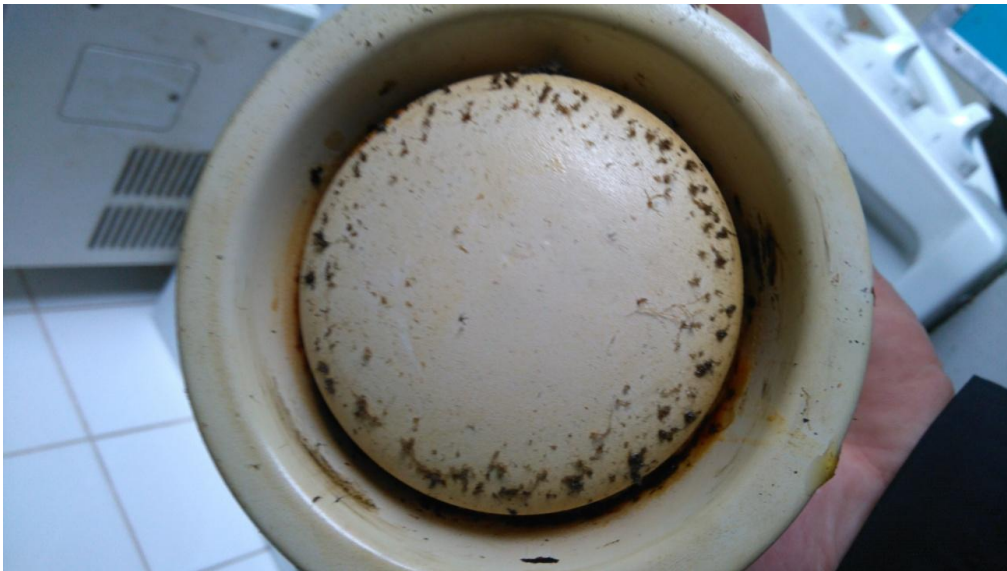
KUVA 4. G 55 -huoneiston keittiön KS 100 -päätelaitte
