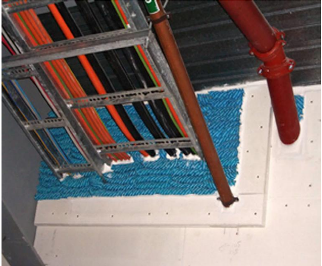
KUVA 12. Palokatko kaapelireitillä (Paleva 2016)
