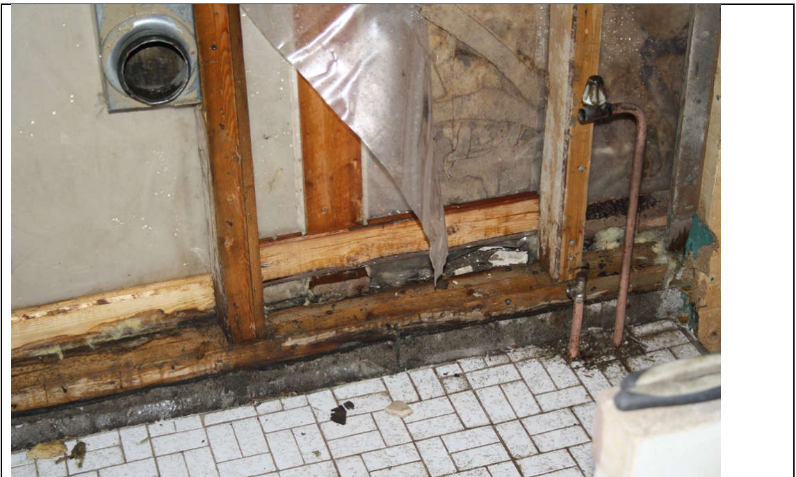
Kuva 3. Mikrobivaurioitunut alaohjauspuu.
