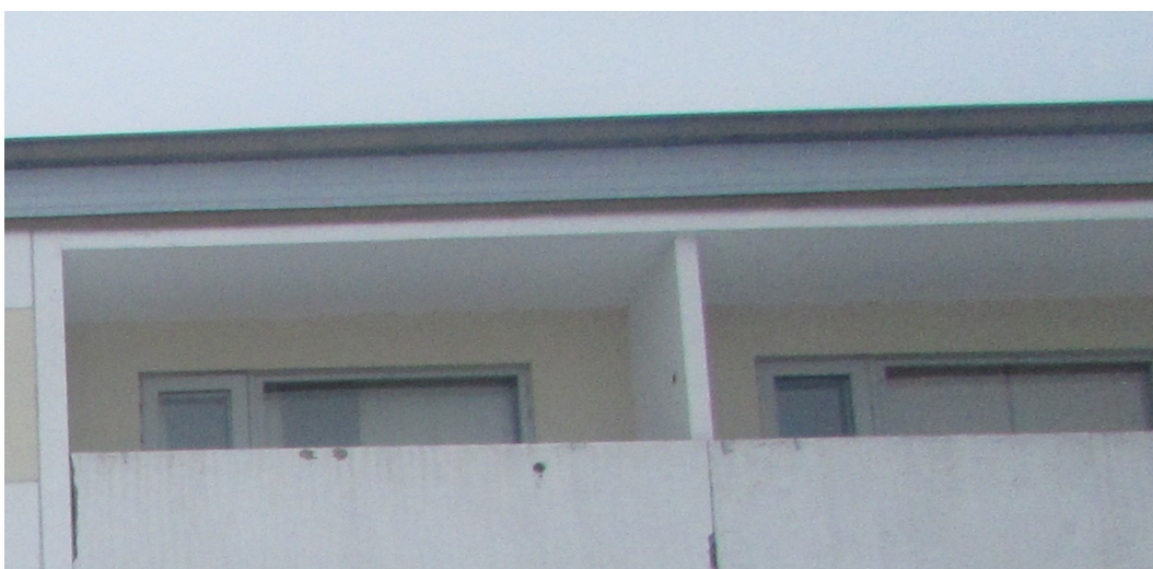
Kuva 10. Parvekekattona toimii paikallavalettu teräsbetoni-laatta
