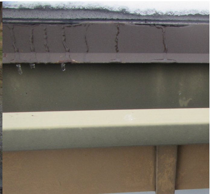
Kuva 5. Huonokuntoiset vanhat rännikourut on korjattu asentamalla uusi kouru vanhan päälle
