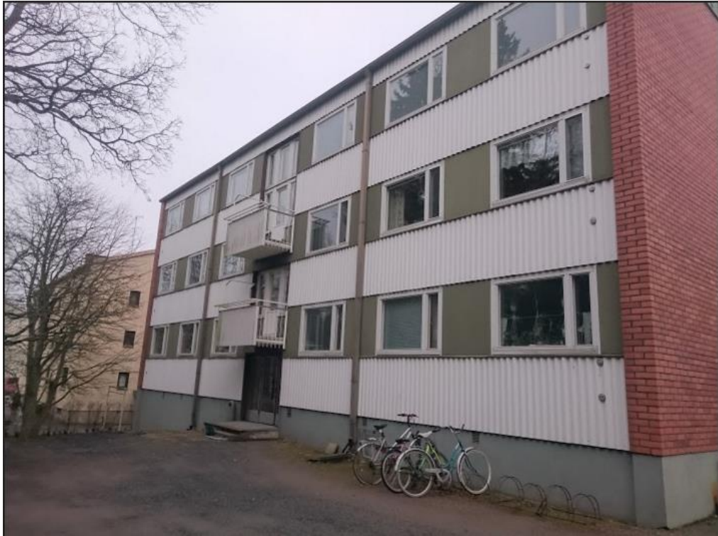
KUVA 14. Asbestilevytyksellä verhoiltu kerrostalon julkisivu Tampereen Härmälässä.
