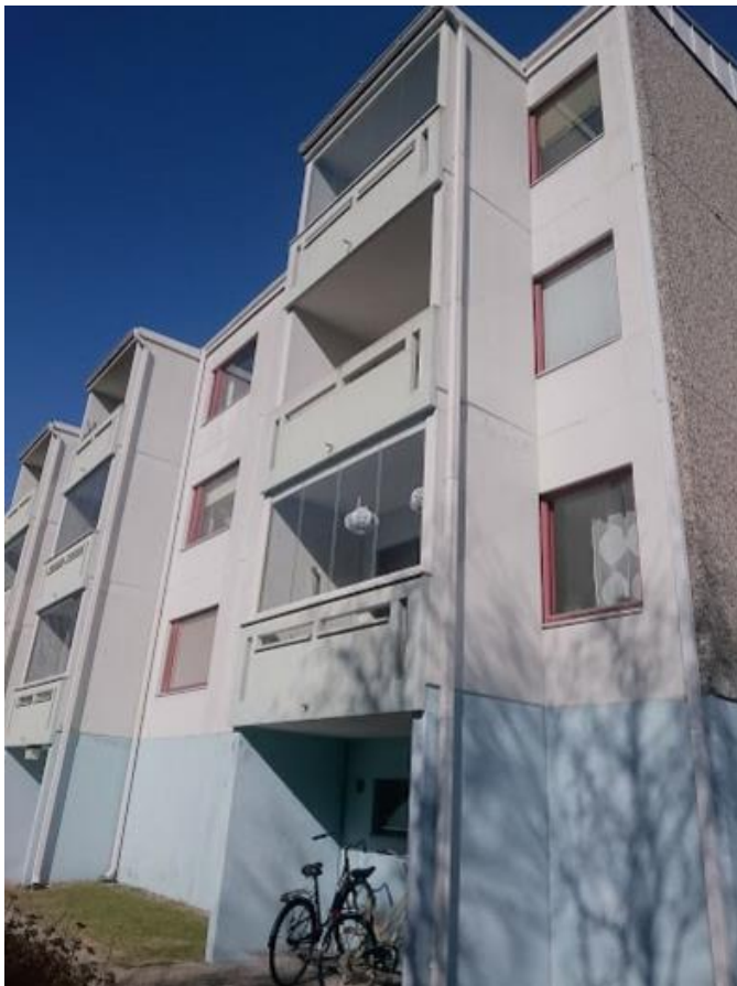
KUVA 18. Rungon ulkopuolinen parveketorni, jossa elementtiparvekelaatat kannatetaan pieliseinillä.
