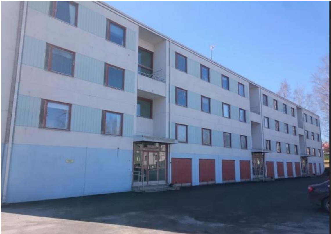
KUVA 17. Suomen ensimmäinen täysin BES-järjestelmällä rakennettu kerrostalo Tampereen Nekalassa.
