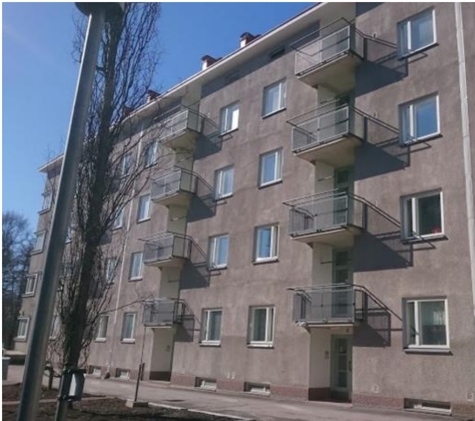
KUVA 8. Vuonna 1939 rakennetun tamperelaisen kerrostalon sisäpihan tuuletusparvekelinjastot.
