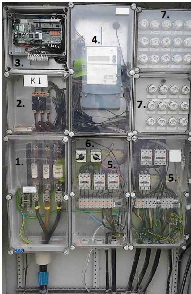
Kuva 1. Katuvalaistuskeskus KV-0117. Numeroin kohdennettu edellä mainitut komponentit (Lassila & Tikanoja 2015).
