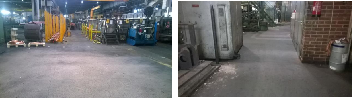
Kuva 1. Lattiat ennen pinnoitusta.
