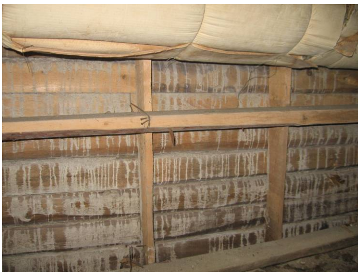
Kuva 9. Muottilaudat jätetty paikoilleen.
