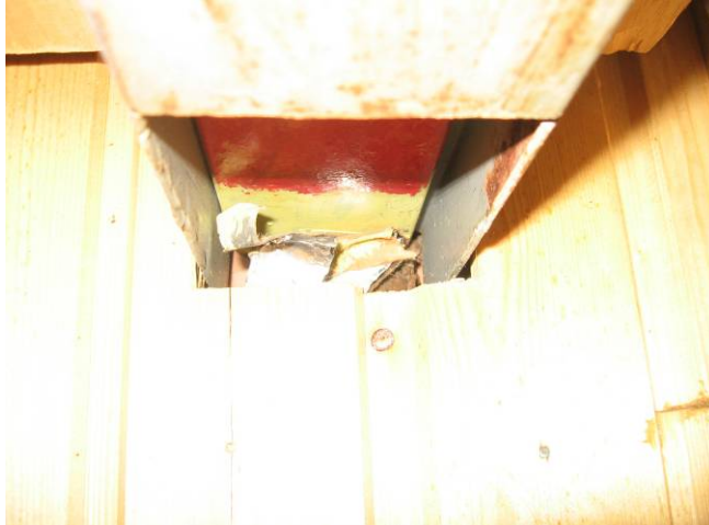
Kuva 46. Reikä saunan lauteiden alla.
