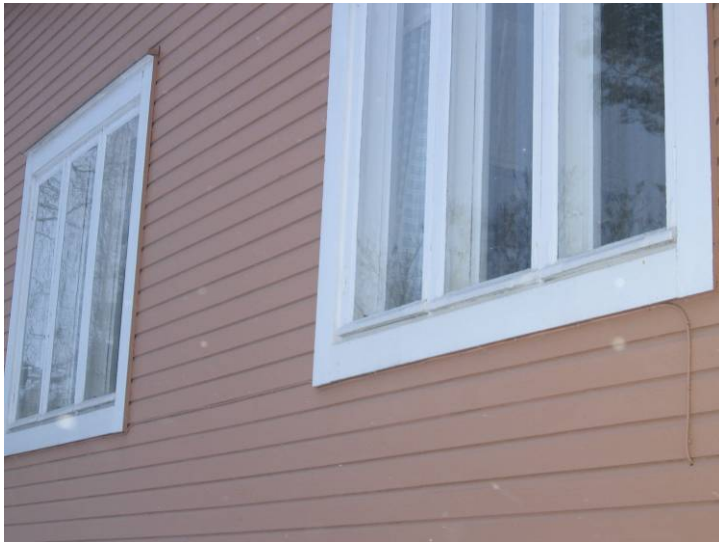
Kuva 29. Ikkunapellitykset puuttuvat.
