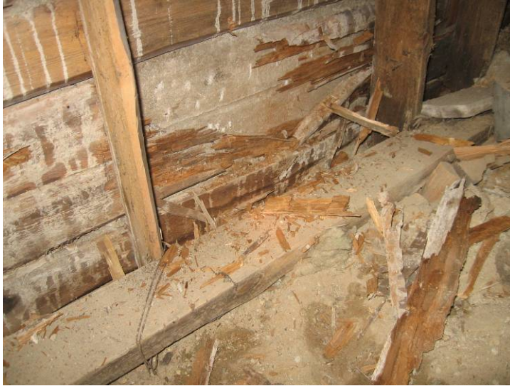
Kuva 10. Lahonneita muottilautoja.
