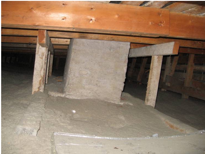
Kuva 14. Yläpohjassa oleva piippu.
