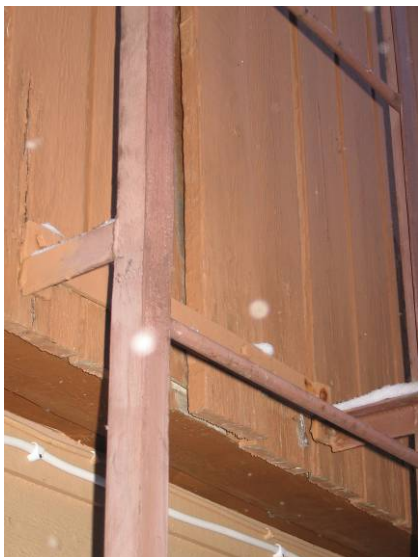
Kuva 21. Laajennuksessa katolle menevät tikkaat ovat hieman irronneet.
