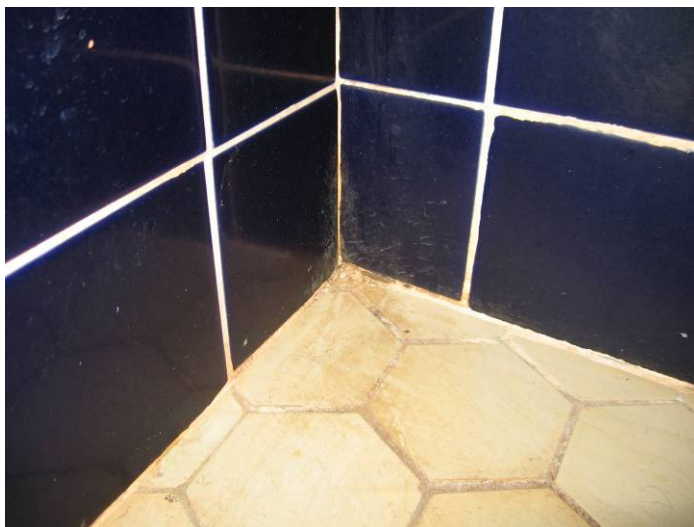
Kuva 42. Kostunut suihkunurkkaus.
