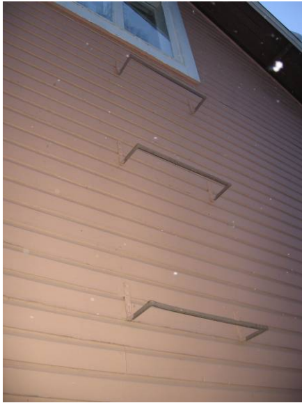
Kuva 19. Tikkaat rintamamiestalossa päädyssä.
