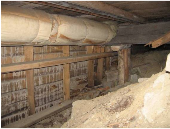
Kuva 4. Alapohjassa kulkevat patteriverkoston putket.
