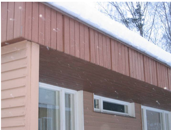
Kuva 24. Sadevesikouru puuttuu.
