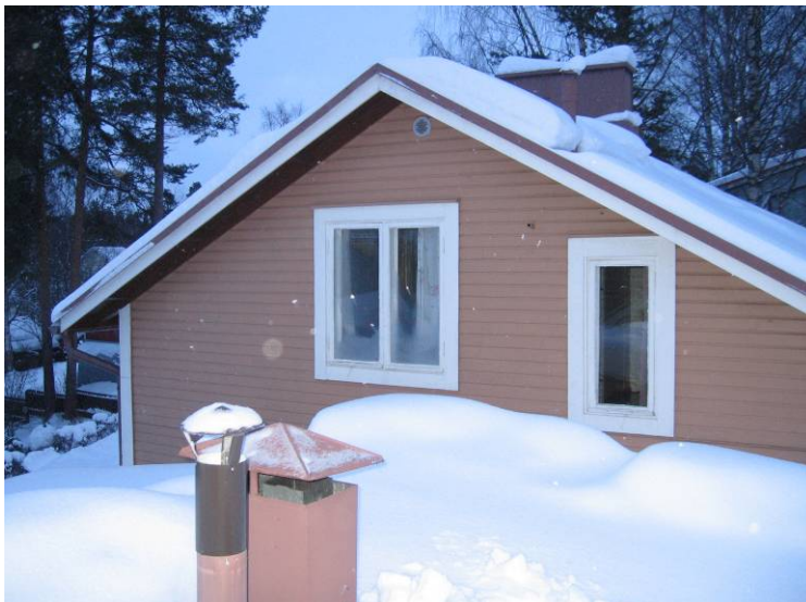
Kuva 18. Talossa on toisella puolella tuuletussäleikkö.
