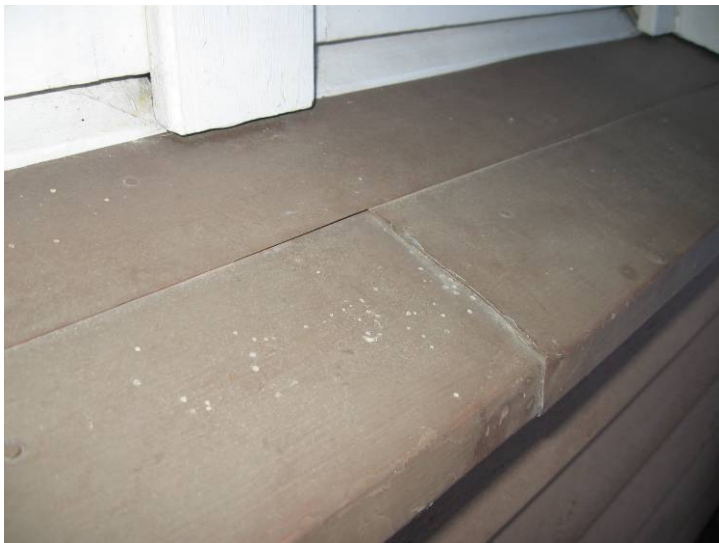
Kuva 30. Ikkunapellitykset muodostettu kappaleista.
