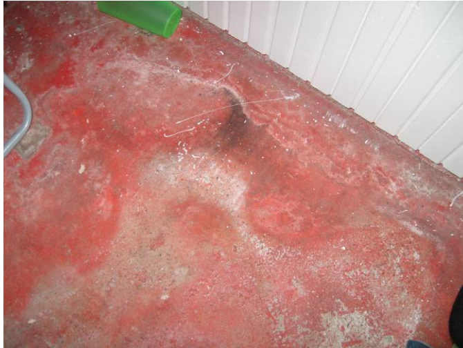
Kuva 37. Pukuhuoneessa raakabetonilattia.
