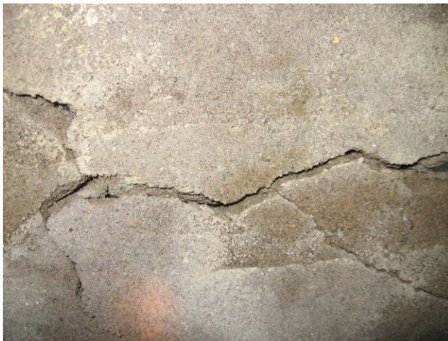
Kuva 8. Sokkelin halkeamia.
