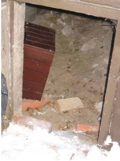
Kuva 1. Alapohjaan menevä luukku.
