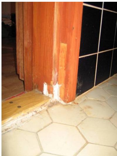
Kuva 41. Pesuhuoneen kynnystä kitattu.
