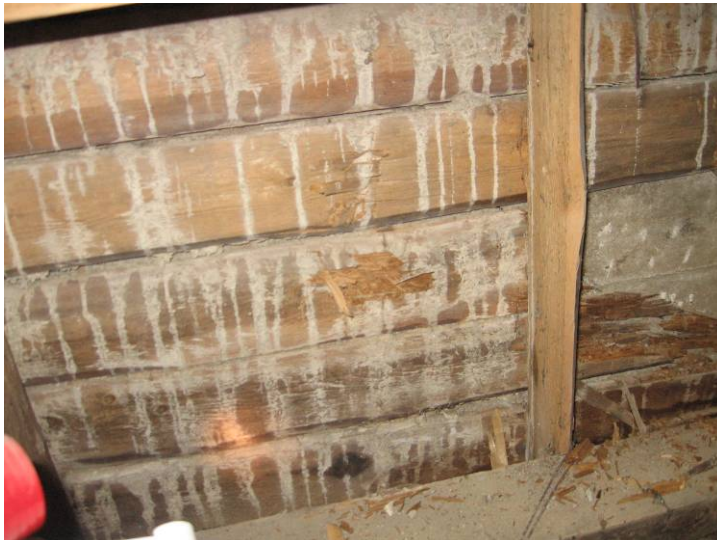
Kuva 11. Sokkelissa olevia muottilautoja.
