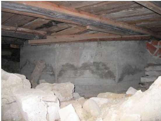
Kuva 2. Alapohjassa rakennusjätettä.
