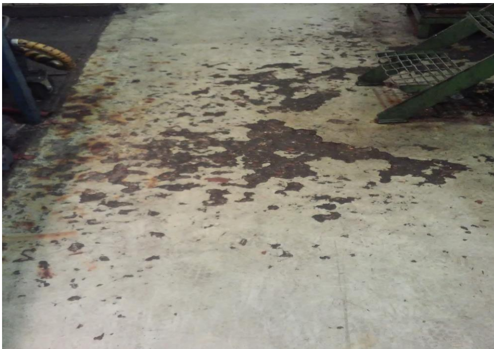
Kuva 9. Lattia ennen projektia.
