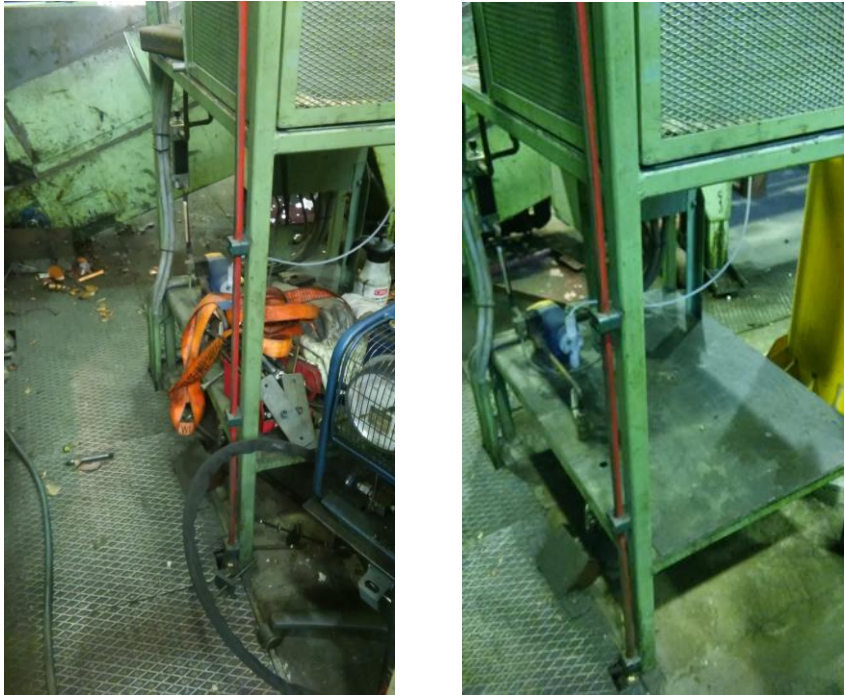
Kuva 13. Rodex-koneiden välissä oleva tila ennen ja jälkeen.
