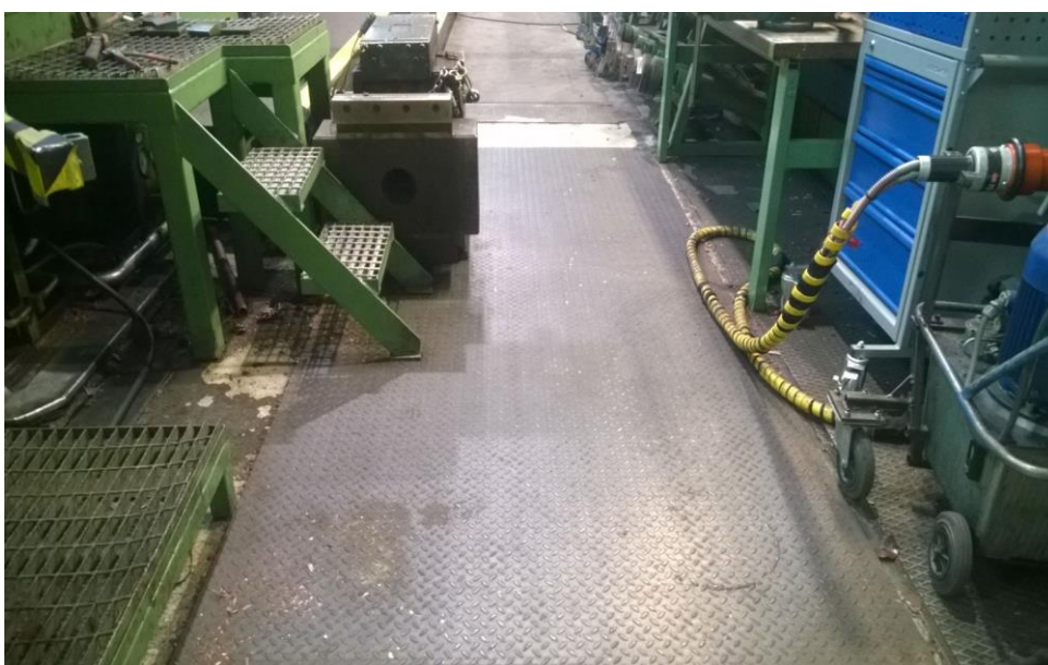
Kuva 10. Lattia projektin jälkeen.
