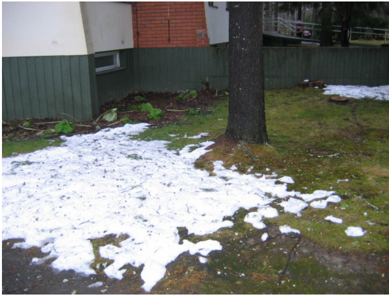
Kuva 7. Maankaadot ovat rakennukseen päin.
