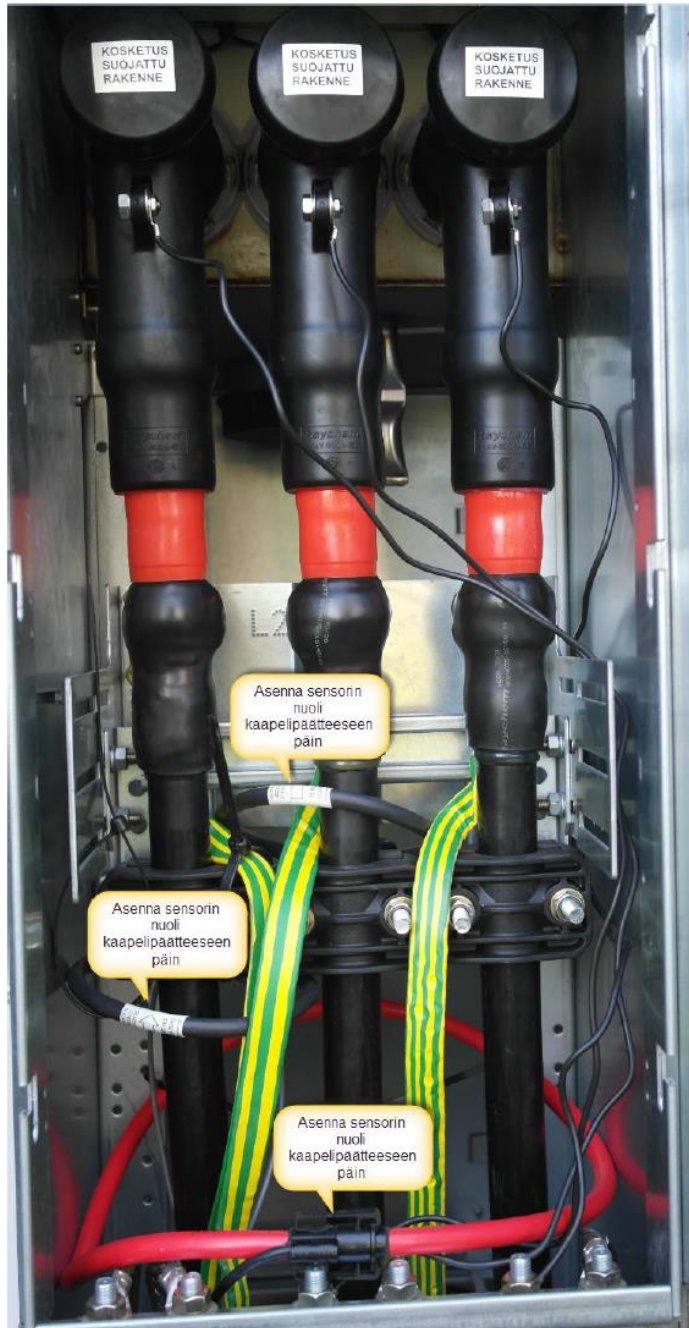
Kuva 4. Harjun muuntamon asennuskuvaa
