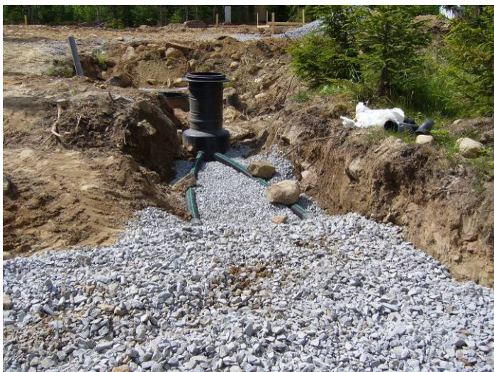
Kuvio 11: Jätevesijärjestelmä, jakokaivosta lähtevä imeytyskenttä
