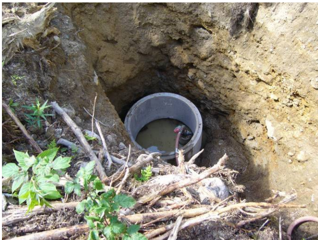
Kuvio 2: Kaivanto vesikaivolle
