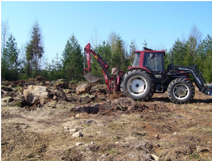
Kuvio 1: Tulevan rakennuspaikan raivaus
