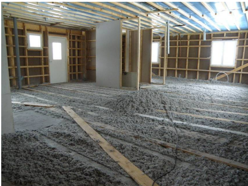
Kuvio 8: Puhallusvillan asennus alapohjaan työmaalla
