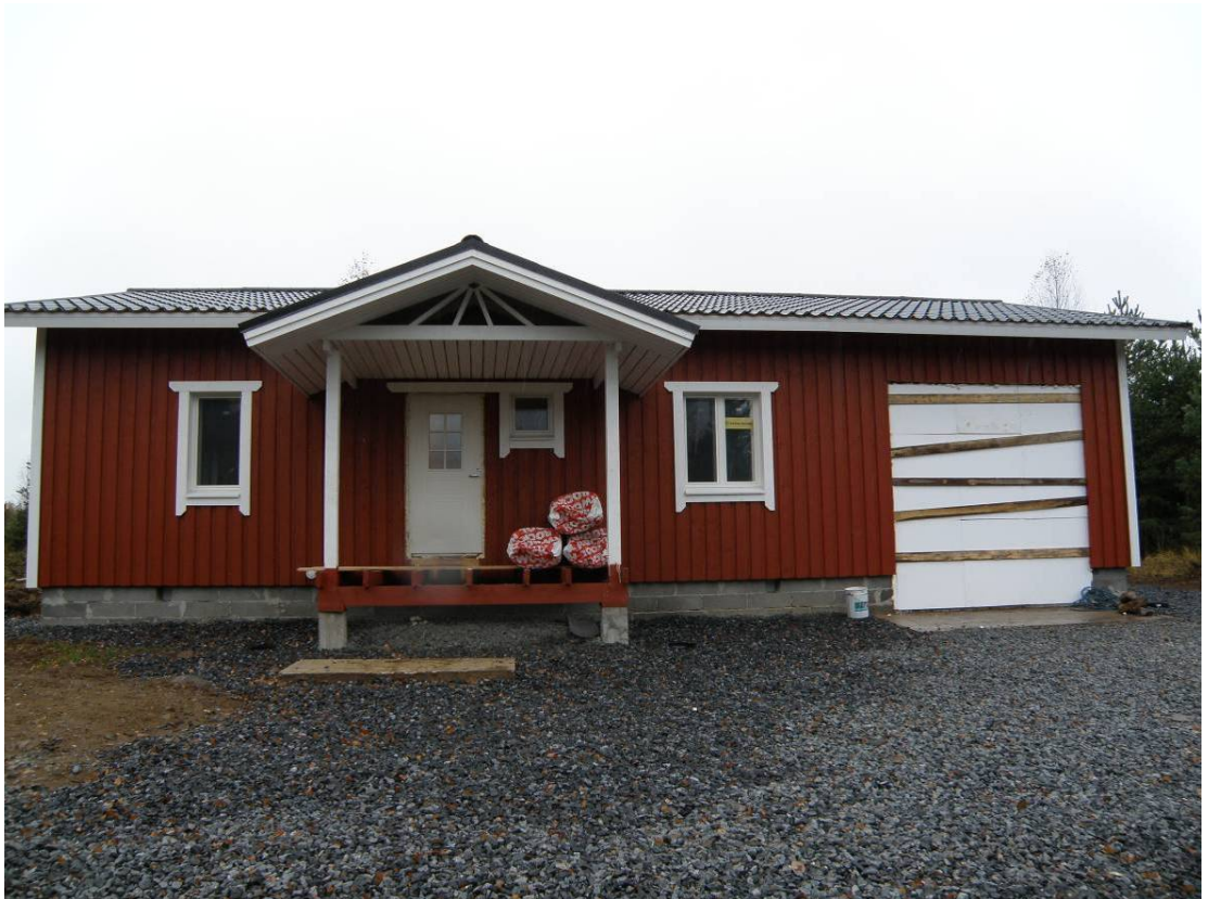
Kuvio 13: Rakennustöiden vaihe marraskuussa 2009
