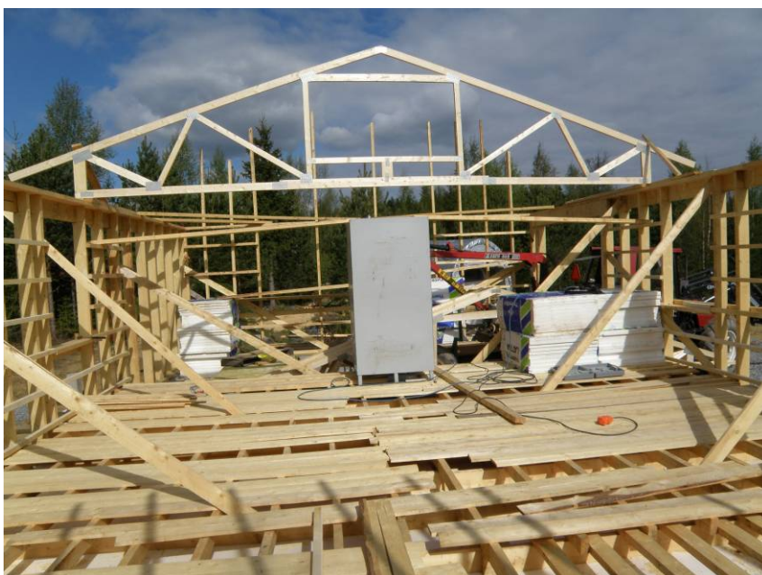
Kuvio 9: Kattoristikoiden asennus työmaalla
