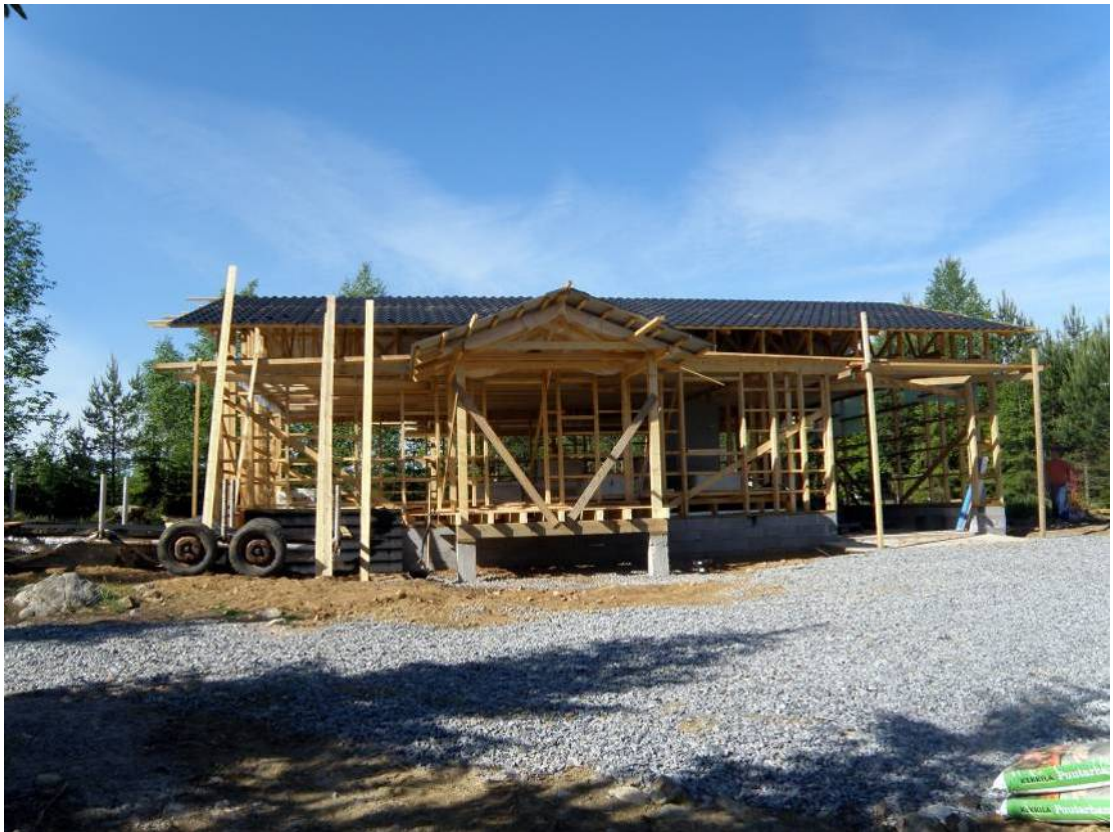
Kuvio 12: Työmaa valmiina rakennekatselmukseen
