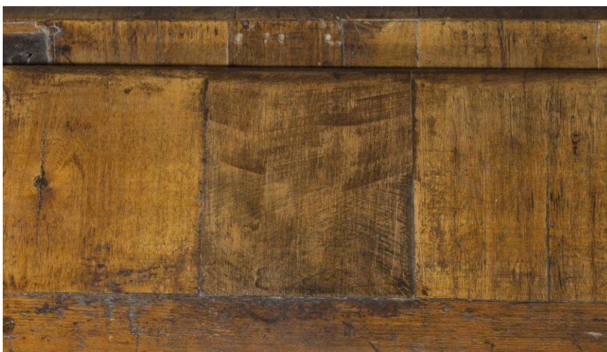
Kuva 8. Vinokannessa oleva myöhempi korjaus.
