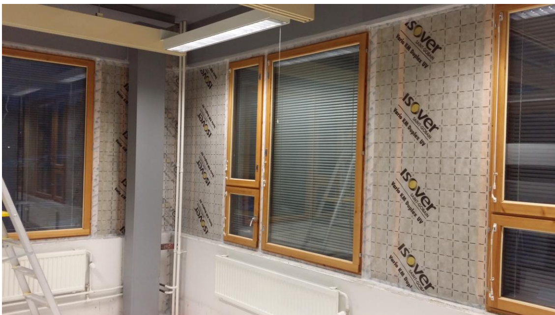
Kuva 2. Ikkunoiden ja höyrynsulun ilmatiiveyden parannus ehkäisee sisäilmaongelmia ja vedon tunnetta tilan käyttäjissä.
