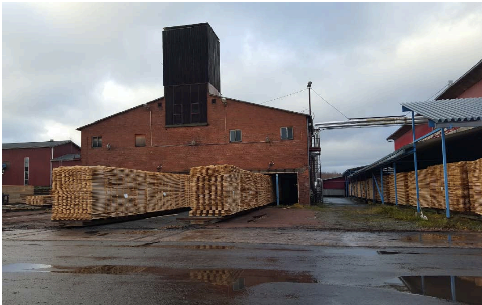
KUVA 6. Vanhan kanavakuivaamon välivarastot.
