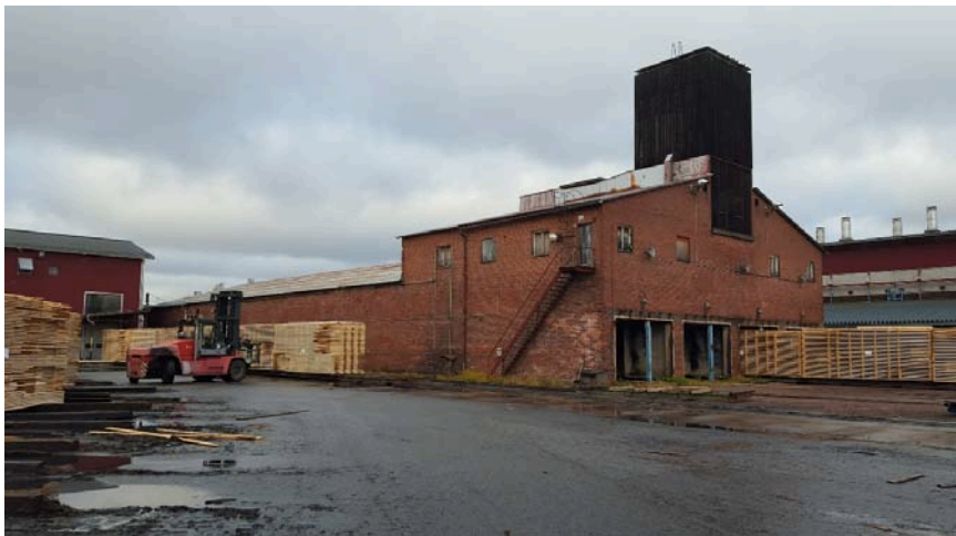
Kuva 13. Tiilestä valmistettu vanha kanavakuivaamo. Etualalla trukki nostaa rimakuormaa pois vaunun päältä.
