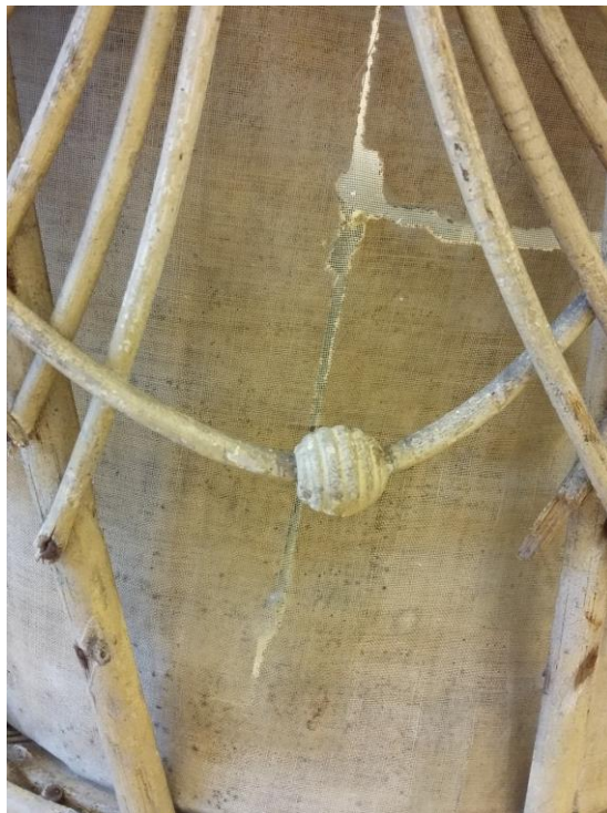
Kuva 15. Repeämän korjaus liimatukikankaan avulla.
