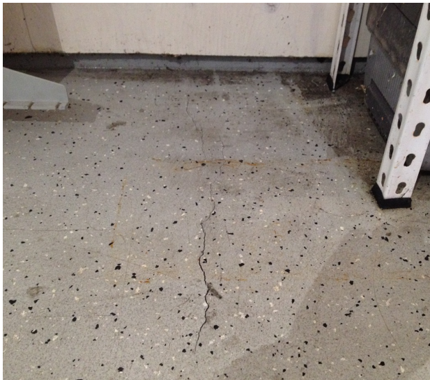
KUVA 5. Lohkeama epoksi-pinnoitteessa
