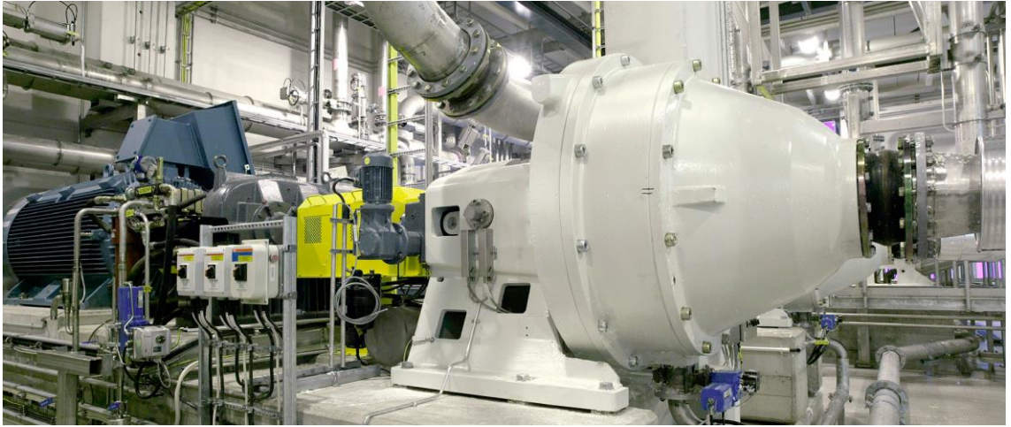
KUVA 6. Valmet OptiFiner RF 4 -jauhin asennettuna betonijalustalle. (Valmet Oy, 2014)
