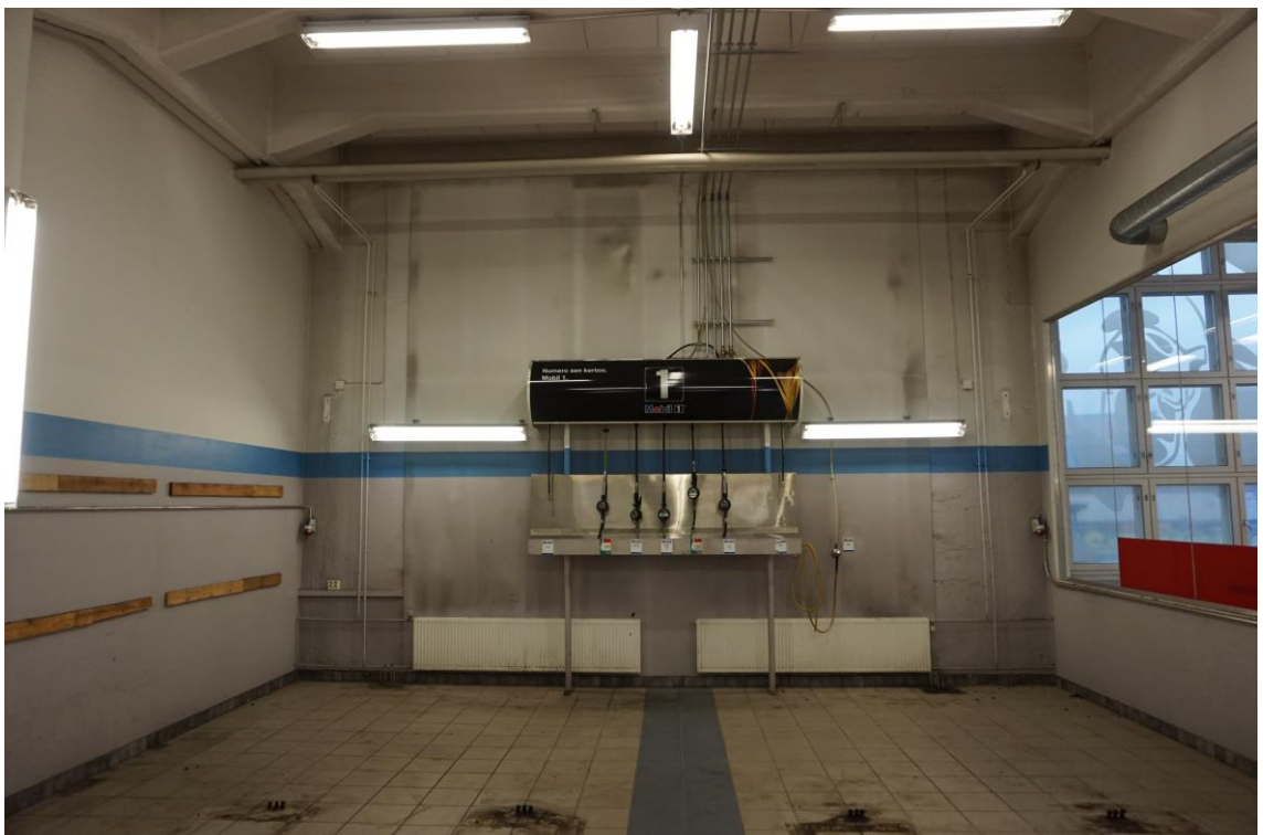
KUVA 5. Korjaamotilat ennen remontointia (Kuva: Mikael Mattila 2016)
