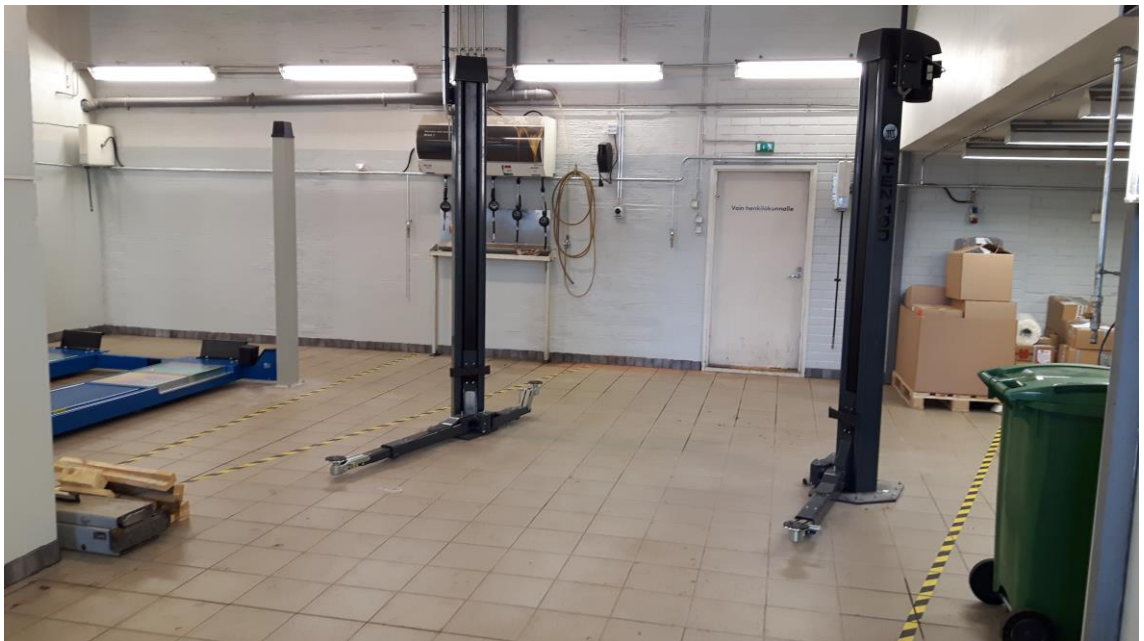
KUVA 11. Uusi kaksipilarinosturi asennettuna (Kuva: Kari Sukanen 2016)
