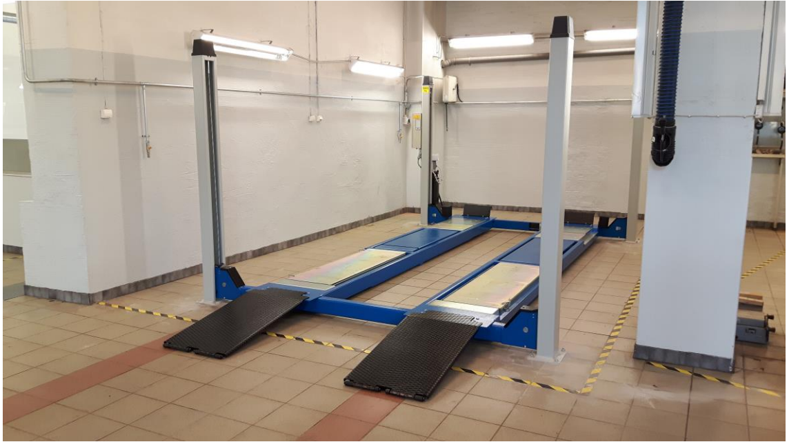
KUVA 10. Uusi siltanosturi asennettuna (Kuva: Kari Sukanen 2016)
