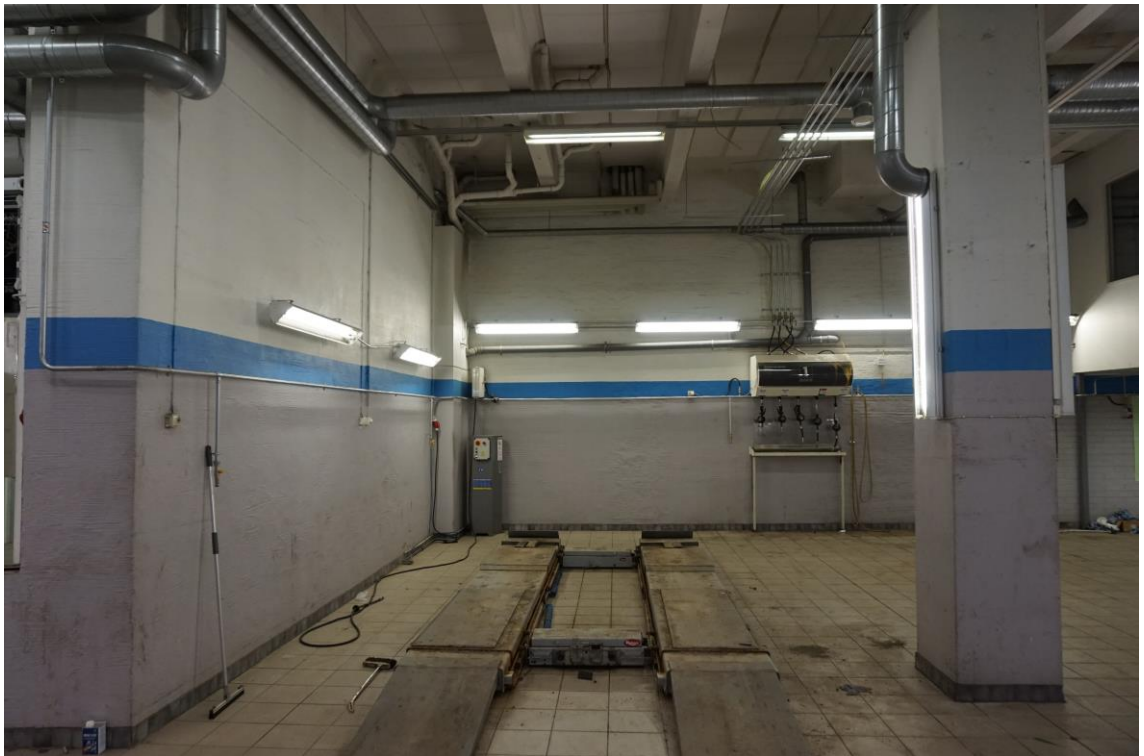
KUVA 4. Korjaamotilat ennen remontointia ja tuleva pyöräsuuntausnosturin paikka (Kuva: Mikael Mattila 2016)
