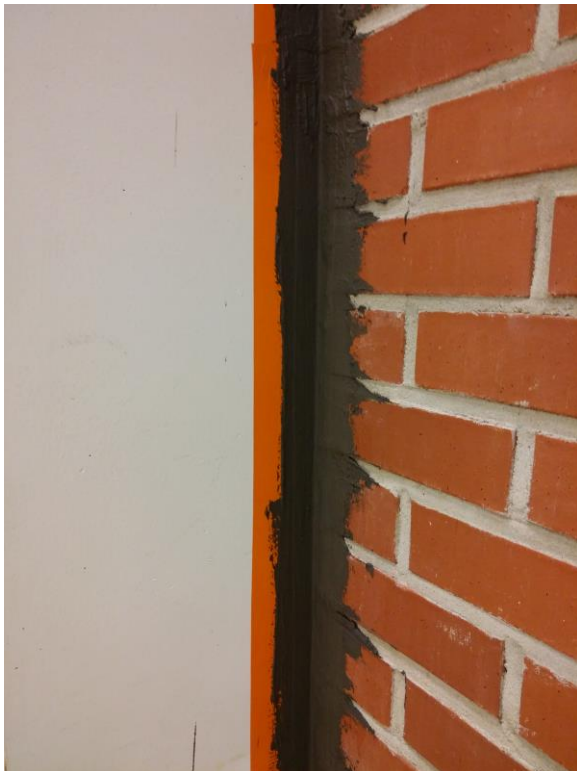
KUVA 5. Pilarin ja tiilikentän liitos
