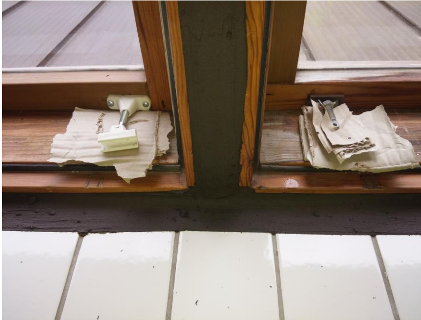
KUVA 6. Ikkunan karmiliitosten tiivistäminen
