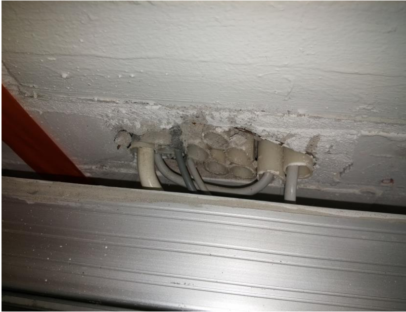
KUVA 7. Sähköjohtojen läpivienti seinärakenteessa
