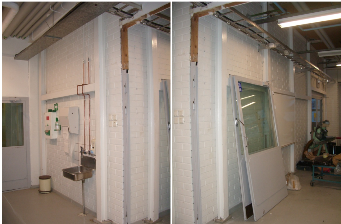
Kuvat 9-10. Seinän vahvistuksia Vammalan ammattikoulussa.
