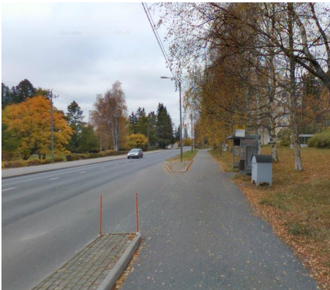
KUVA 30. Julkulansairaala P -pysäkiltä puuttuu Esteetön pysäkki -luokalta vaadittu korotettu odotus-tila. (Globe Spotter 2016)
