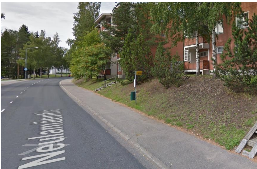
KUVA 19. Neulamäentie 11 – 13 –pysäkiltä on nousijoita 80/vrk. Katoksen rakentaminen vaatii tukimuurin tekemistä luiskaan. (Google Maps 2016)
