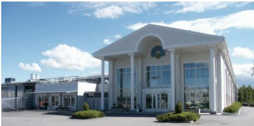
Kuva 1. Vaconin tehdas ja pääkonttori Vaasassa ( www.vacon.fi )
