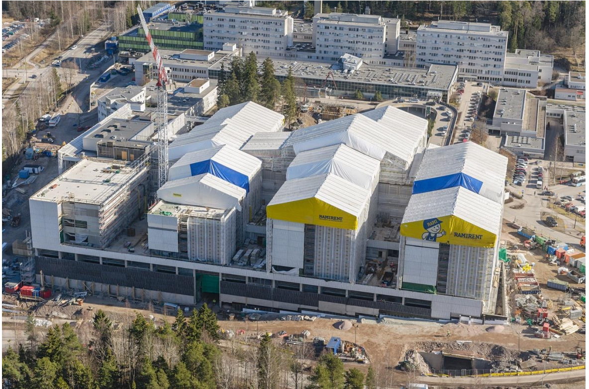
Kuva 1. Suojattuja rakennuksia. (Telineet ja sääsuojat, [viitattu 16.3.2016].)
