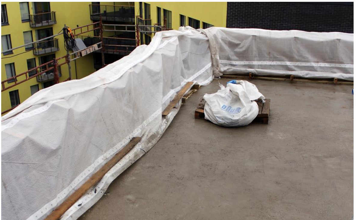
Kuva 2. Ulkoseinäelementin suojaus. (Rakenteiden suojaus kosteudelta, [viitattu 14.3.2016].)
