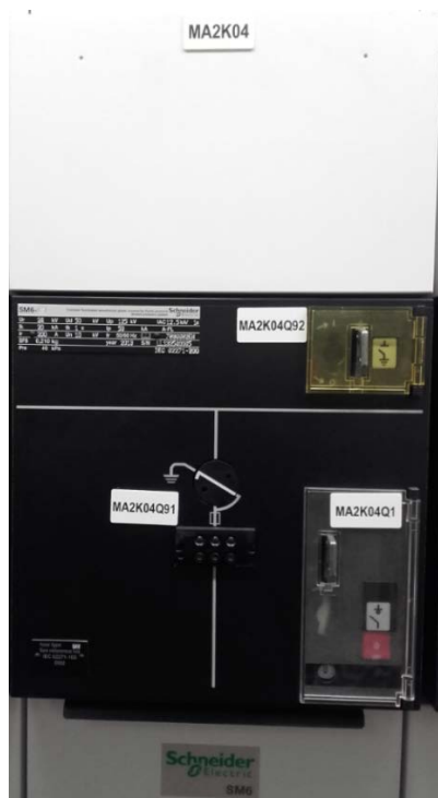
KUVA 7. Erotin MA2K04Q01, varaus tulevaisuuden laajennuksiin. (Väisänen, 2016)
