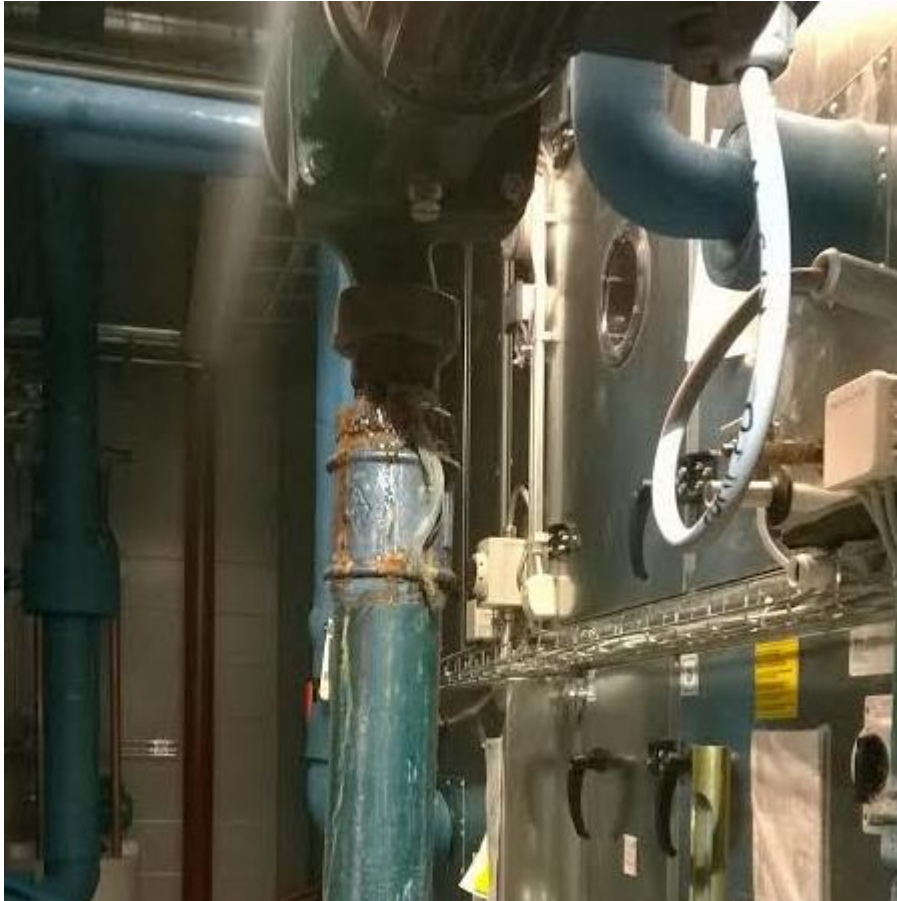
Kuva 7. Putkivuoto IV-konehuoneessa
