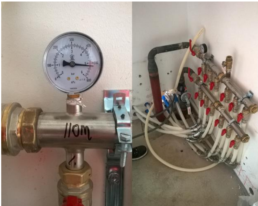
Kuva 4. Espoon sairaala, ajoluiskan sulanapidon jakotukin paineet
