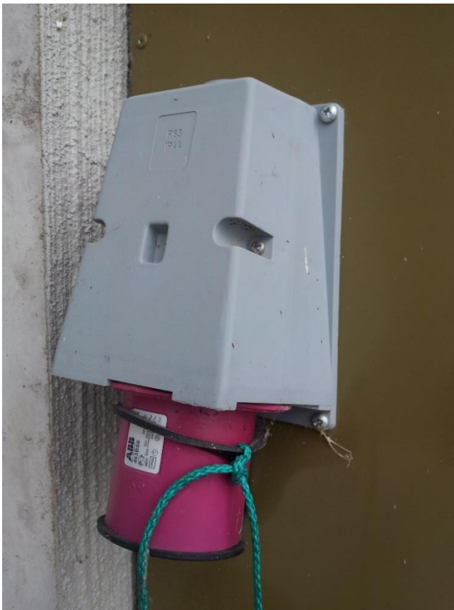
KUVA 11. Varavoimaliitännä
