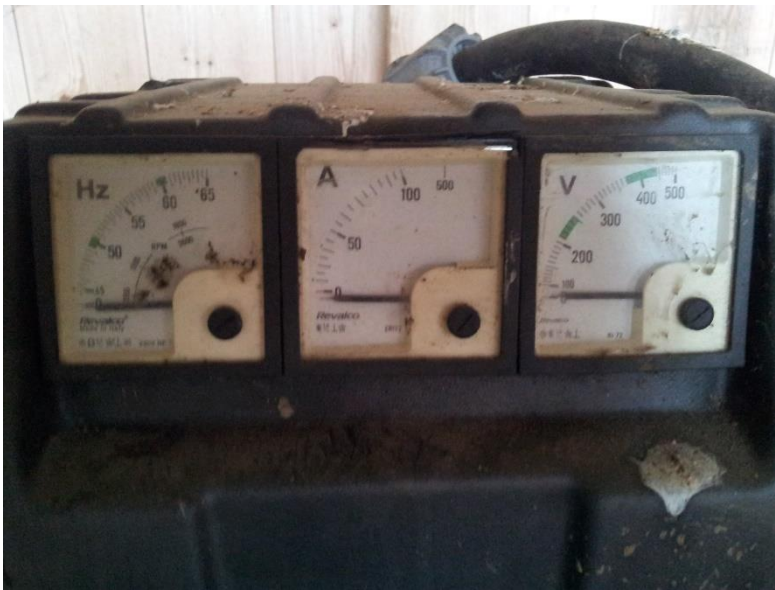
KUVA 9. Aggregaatin taajuus-, virta- ja volttimittarit
